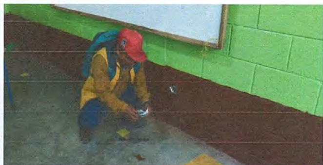
Foto 9: Proceso de Reparación de Sistema Eléctrico
