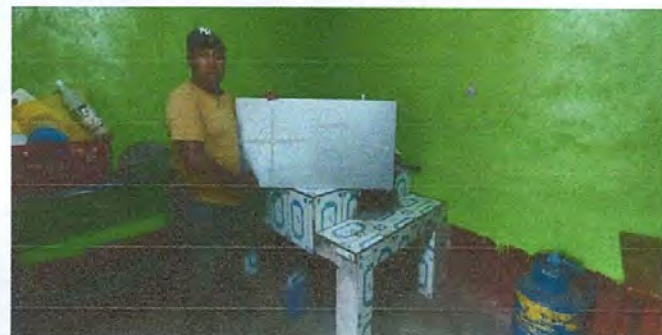
Foto 11: Proceso de Reparación de cocina
