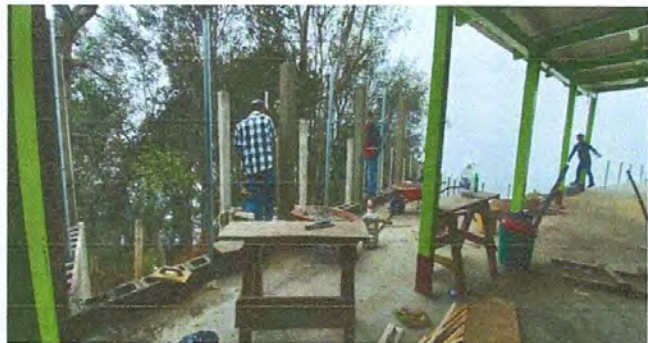
Foto 7: Proceso de Muro perimetral
