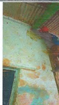
Foto 10: Proceso de Reparación de Sistema Eléctrico
