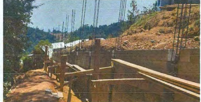
Foto 14: Proceso de Reparación de Muro de Contención
