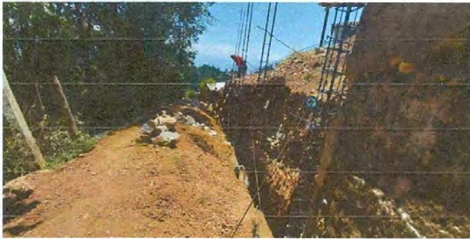
Foto 13: Proceso de Reparación de Muro de Contención
