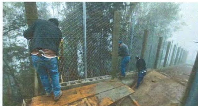
Foto 8: Proceso de Muro perimetral
