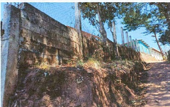
Foto 7. Reparación de muro de contención
