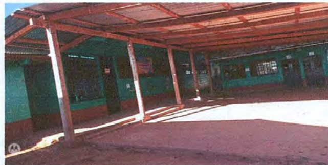
Foto 2. Pintura en muros exteriores e interiores.
