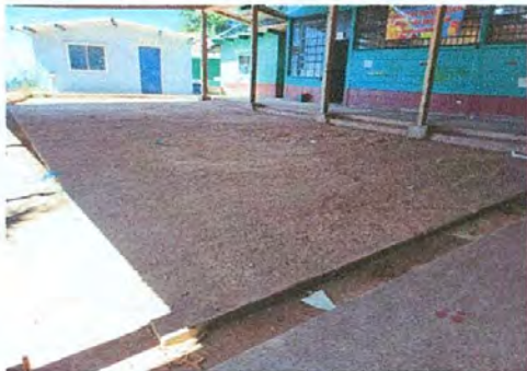
Foto 1: Piso-Reparación de piso de torta de concreto.
