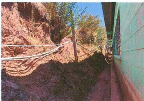
Foto 3. Reparación de Red de agua potable.
