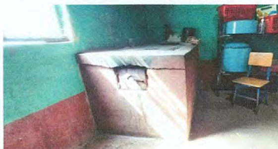
Foto 6. Reparación de cocina
