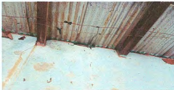
Foto5. Reparación Sistema eléctrico
