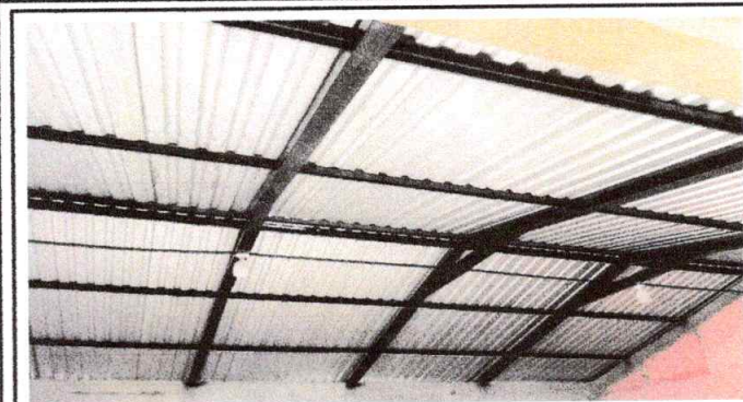
Foto1: SUSTITUCIÓN DE LAMINA POR LAMINA TROQUELADA, VIGAS DE MADERA POR METAL, LAMPARAS POR FOCOS AHORRADORES
