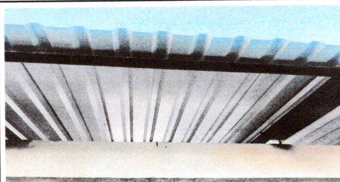
Foto 2: VIGA DE CORONA
