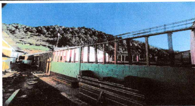
Foto1: REPARACIÓN DE VIGA DE CORONA EN MURO DE AULAS
