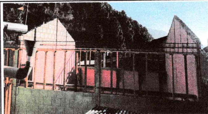
Foto 2: REPARACIÓN DE PAREDES DE AULAS
