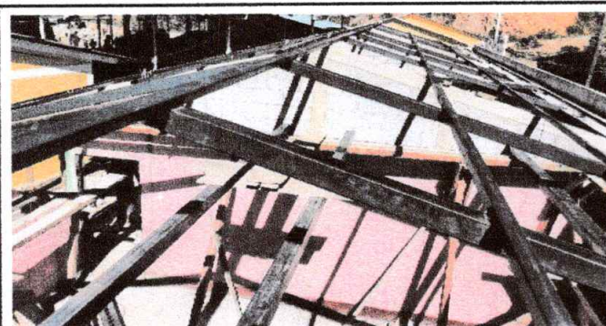
Foto 5: SUSTITUCIÓN DE VIGA DE MADERA POR META
