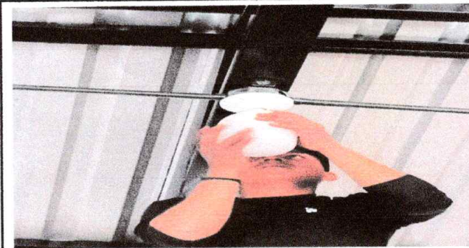
Foto 6: SUSTITUCIÓN DE LAMPARAS POR FOCOS AHORRADORES
