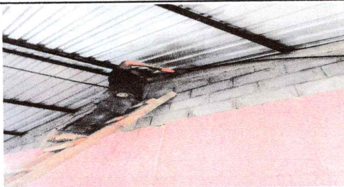
Foto1: INSTALACIÓN DE TUBODUCTO
