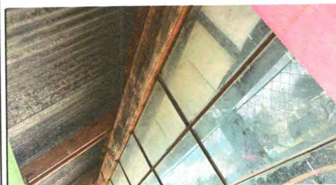
FOTO 5: REPARACIÓN DE VIGA CORONA
