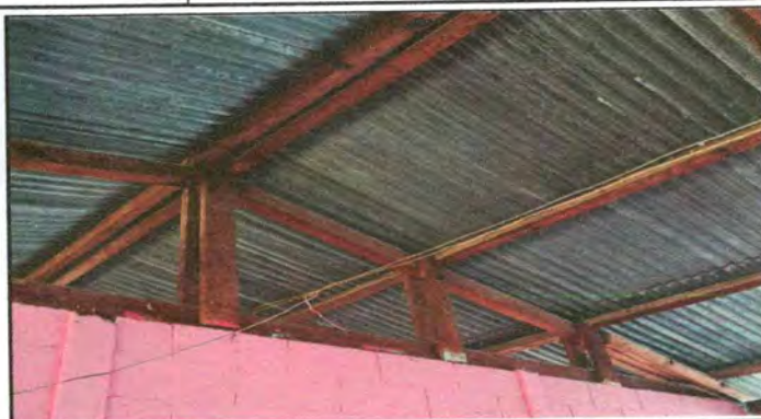
Foto 2: SUSTITUCIÓN DE SOPORTE DE MADERA POR ESTRUCTURA DE METAL DE TECHO
