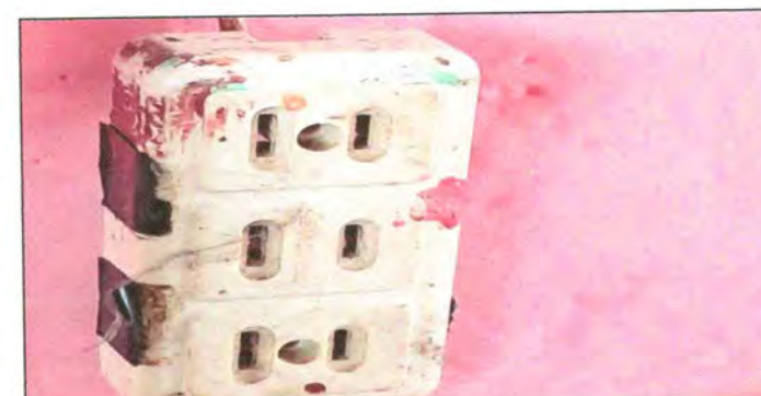
Foto 6: SUSTITUCIÓN DE TOMACORRINETES
