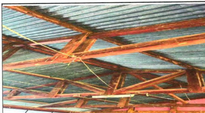
FOTO3: SUSTITUCION DE VIGAS DE MADERA POR METAL
