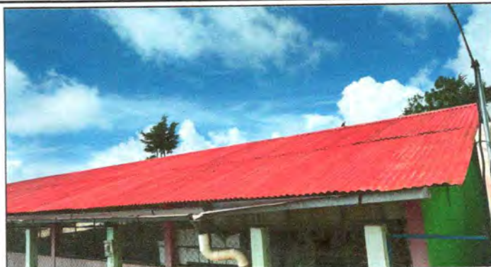
FOTO 2: SUSTITUCIÓN DE LÁMINA POR LÁMINA
