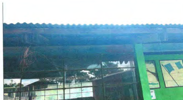
FOTO 4: REPARACIÓN DE ESTRUCTURA DE MADERA POR METAL
