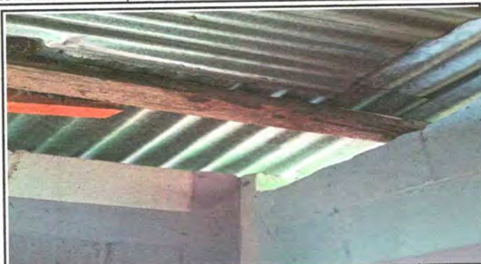
Foto1: SUSTITUCIÓN DE LAMINA
