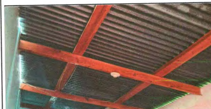
Foto 5: SUSTITUCIÓN DE FOCOS AHORRADORES
