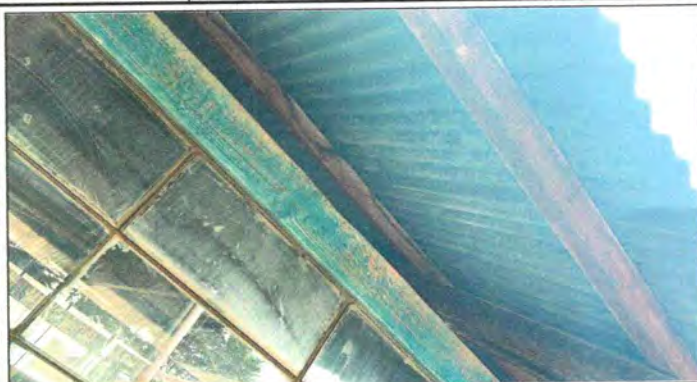
FOTO 1: SUSTITUCIÓN DE LAMINA POR LAMINA
