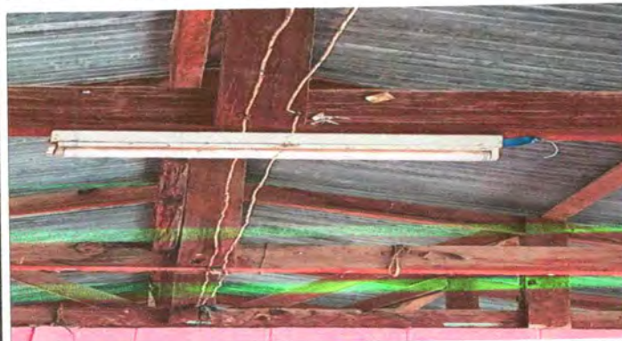
FOTO 3: SUSTITUCION DE LAMPARAS POR FOCOS AHORRADORES
