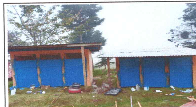
Foto 4: Las 6 puertas de metal del Servicio Sanitario finalizado y con su respectivo color Según el código del programa de Remozamiento.
