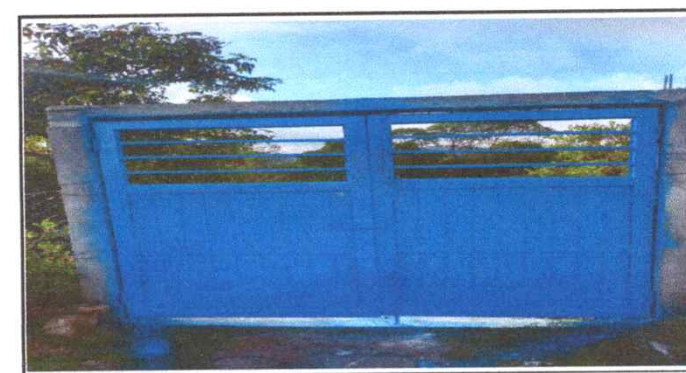
Foto 6: El portón de metal de dos hojas, colocado y finalizado con su respectivo color.
