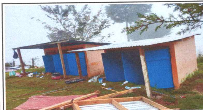
Foto 3: Las puertas de metal del Servicio Sanitario ya están colocados.
