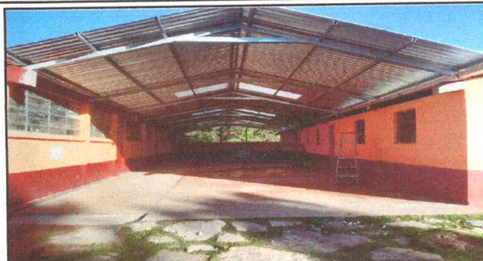
Foto 2: El techo completo del corredor del Centro Educativo.
