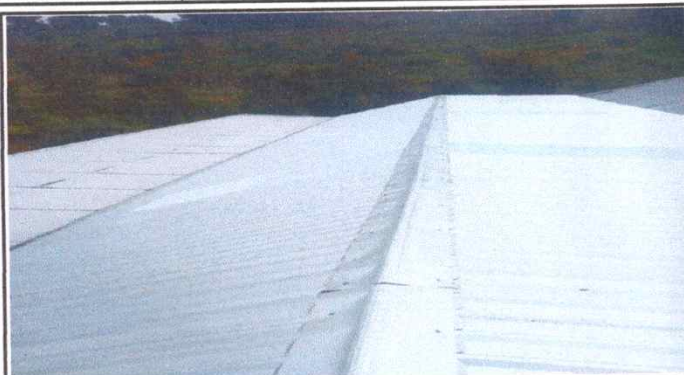
Foto 1: El techo ya finalizado con lámina troquelada Aluzinc .
