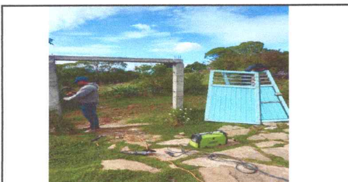
Foto 5: Quitando el portón antiguo y colocando el portón nuevo de metal.
