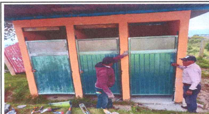
Foto 3: Las puertas de metal de los sanitarios ya estan colocadas.
