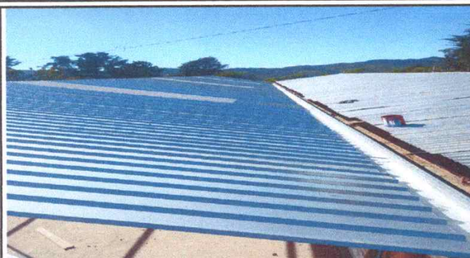
Foto1: Las láminas Azulinc y las costaneras ya están colocadas en el corredor del Centro Educativo.
