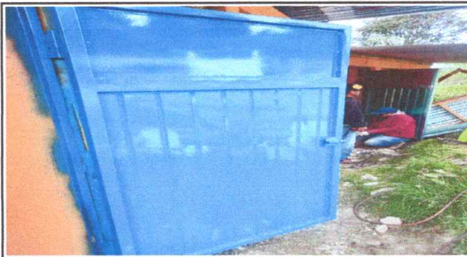
Foto 4: Las puertas de metal estan siendo colocandas y pintandas.
