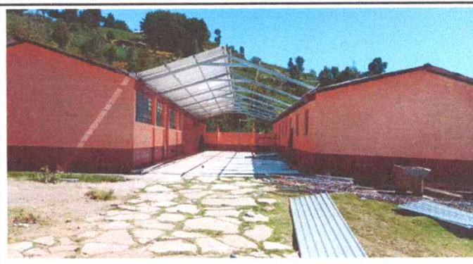
Foto 2: El techo del corredor ya estan colocadas las costaneras y las láminas Aluzinc en una ilada.
