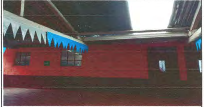
Foto 8: La galera que esta construida por el momento tiene como soporte reglas delgadas y está muy baja. Ya con los arreglos quedará sobre costanera y alta.
