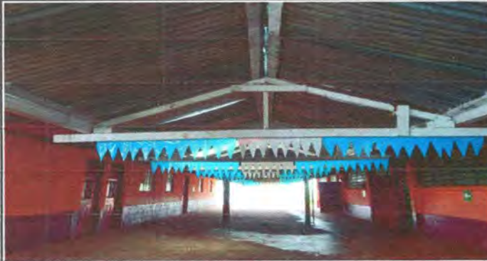
Foto 7: Las laminas que colocaron eran de una galera que había antes en la escuela por eso tienen muchos agujeros y por lo mismo es importante cambiarlas.
