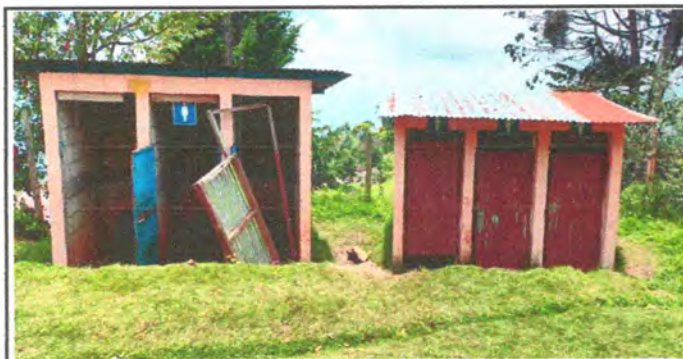
Foto 5: Las puertas es necesario cambiarlas porque estan deterioradas.
