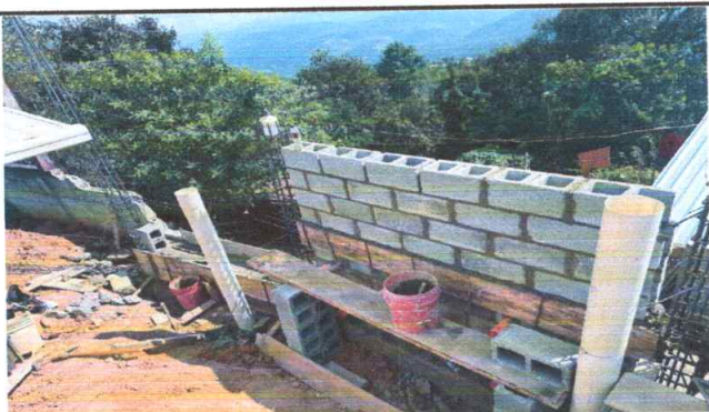
FOTO 3: colocación de block para muro perimetral
