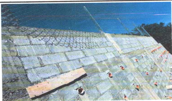
Foto 5: así quedó el muro al haber terminado
