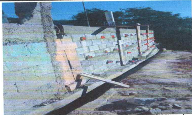
Foto1: casi terminando el muro
