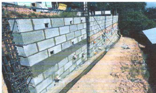
Foto 5: casi terminando el muro de contención
