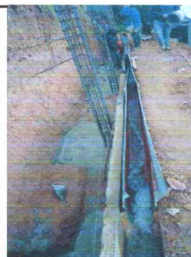
FOTO 3: fabricación de columnas y puesta de columnas
