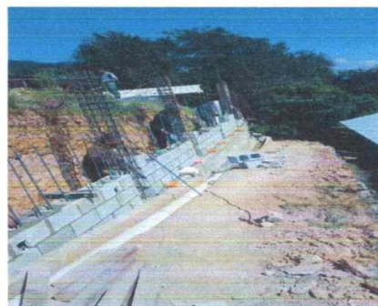
FOTO 4: levantado del muro con block para muro
