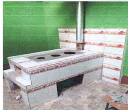
Foto 12: Reparación de cocina
