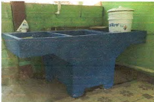
Foto 11: Reparación de cocina
