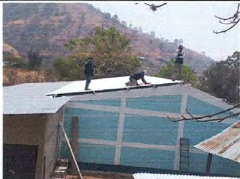
Foto 1: Cubierta de lámina
