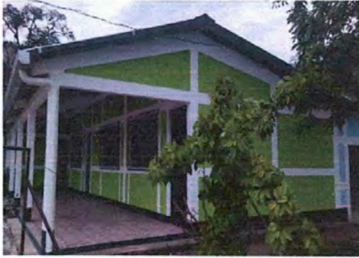
Foto7: Pintura en interiores y exteriores
