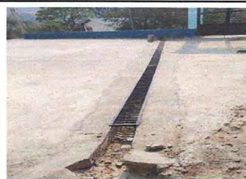
Foto 6: Cunetas de concreto
