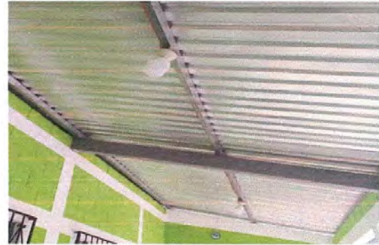
Foto 8: Reparación de sistema eléctrico
