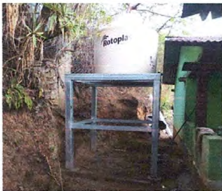
Foto 9: Reparación y mantenimiento de sisterna/Depósitos de agua
