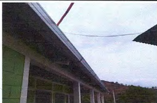
Foto 5: Canales y bajadas de agua pluvial
