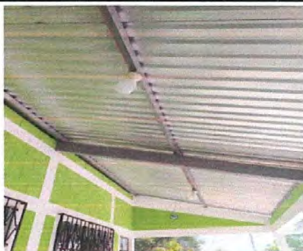
Foto 2: Estructura de techo
