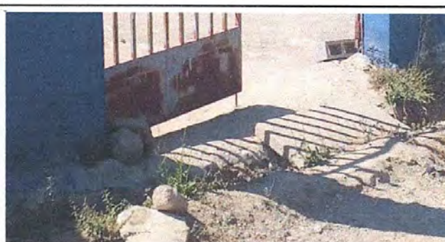
Foto 6: CUNETAS DE CONCRETO
