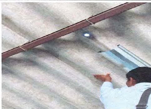
Foto 1: CUBIERTA DE LÁMINA
