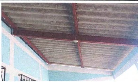
Foto 2: ESTRUCTURA DE TECHO
