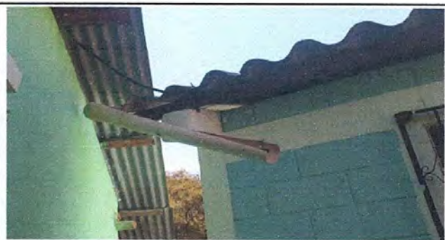
Foto 5: CANALES Y BAJADAS DE AGUA PLUVIAL
