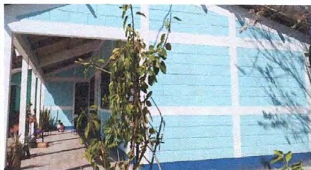
Foto 7: PINTURA EN MUROS EXTERIORES E INTERIORES
