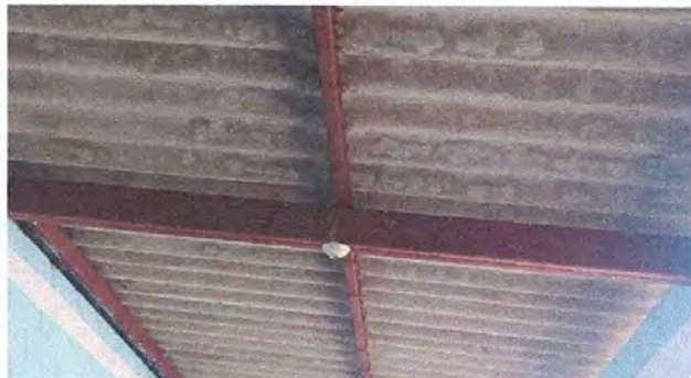
Foto 8: REPARACIÓN DE SISTEMA ELÉCTRICO
