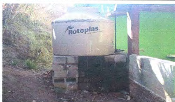
Foto 9: REPARACIÓN Y MANTENIMIENTO DE CISTERNAS/DEPÓSITOS DE AGUA
