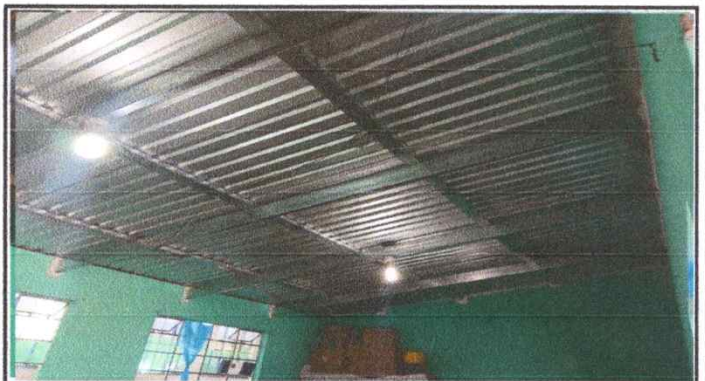
Foto 4: cambio de Estructura de madera por estructura de metal
