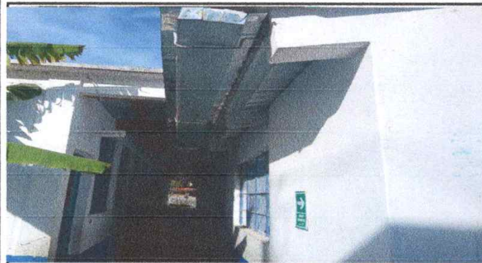
Foto 3: Estructura de metal
