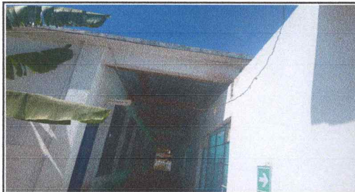
Foto 3: Cambio Estructura de madera picados y en mal estado
