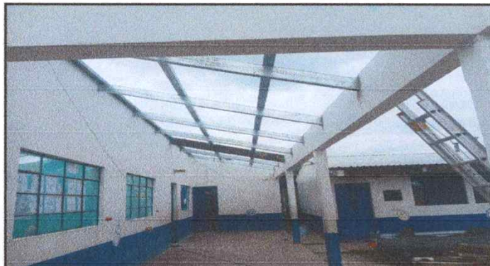
Foto 4: Cambio de Estructura de madera por metal
