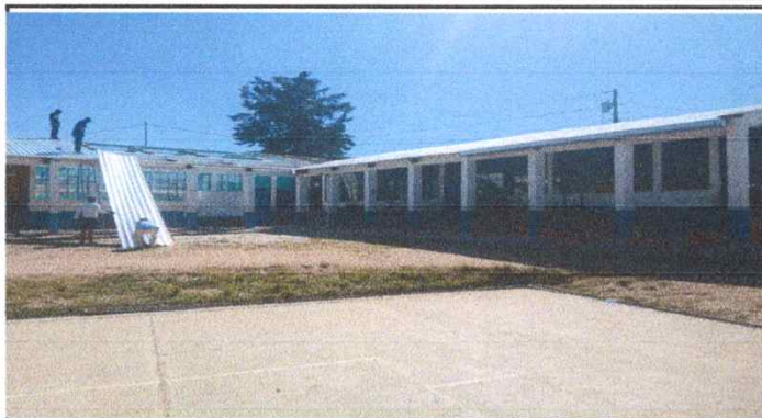
Foto1: Cambio de Techado de lámina
