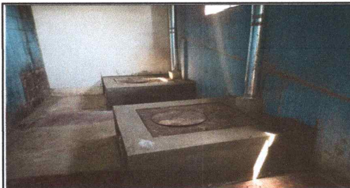
Foto 9: Sustitución de chimenea de metal.
