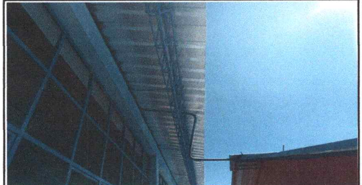
Foto 4: Mantenimiento a estructura de soporte de metal.
