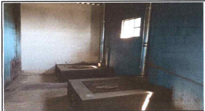
Foto 10: Sustitución de estufa rural y base.
