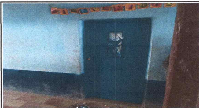
Foto7: Reparación de chapas
