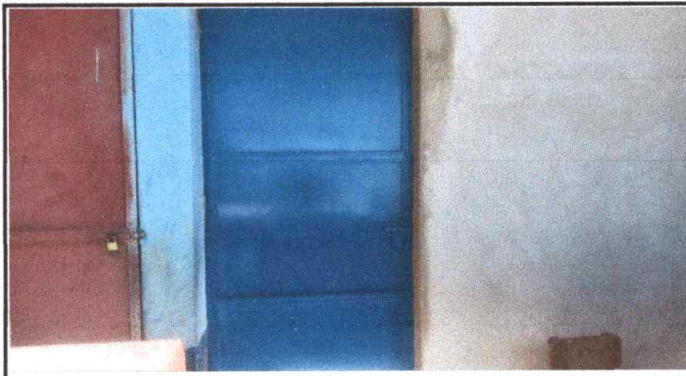
Foto 8: Pintura y lijado de puerta de metal.
