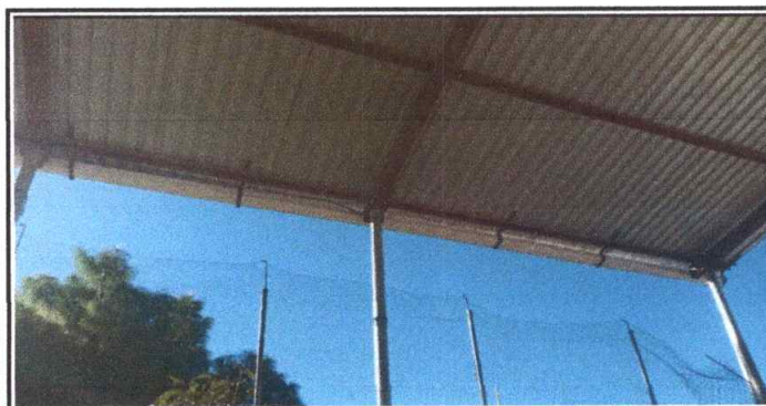
Foto 11: Sustitución de canal PVC
