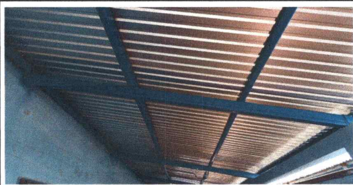
Foto 3: Sustrucción de elementos de fijación.
