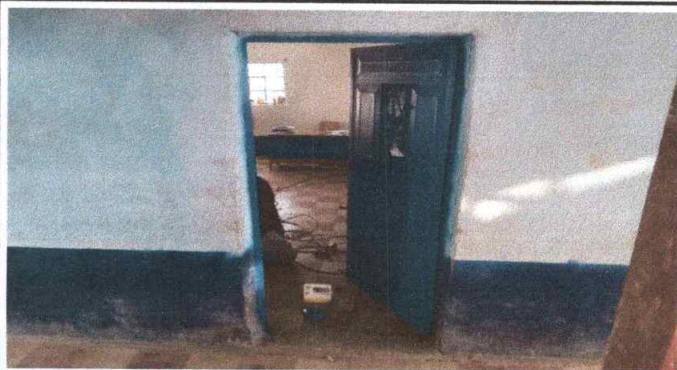
FOTO 7: REPARACION DE CHAPAS
