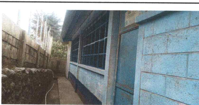
FOTO 6: SUSTITUCION DE ESTRUCTURA DE METAL DE VENTANA
