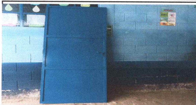
FOTO 8: PINTURA Y LIJADO DE FUERTA DE METAL
