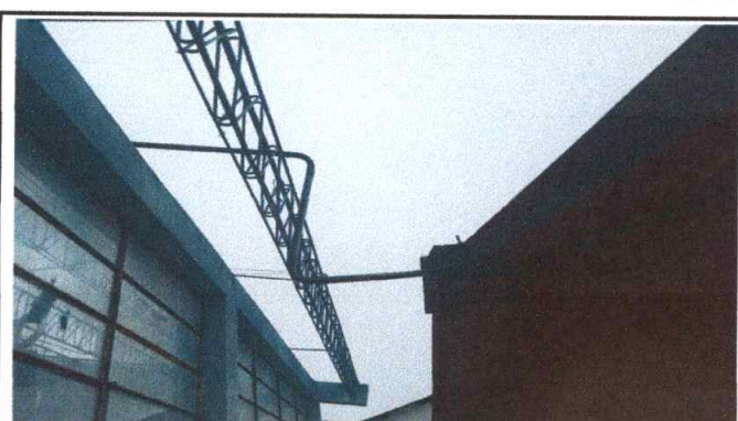
FOTO 4: MANTENIMIENTO A ESTRUCTURA DE SOPORTE DE METAL
