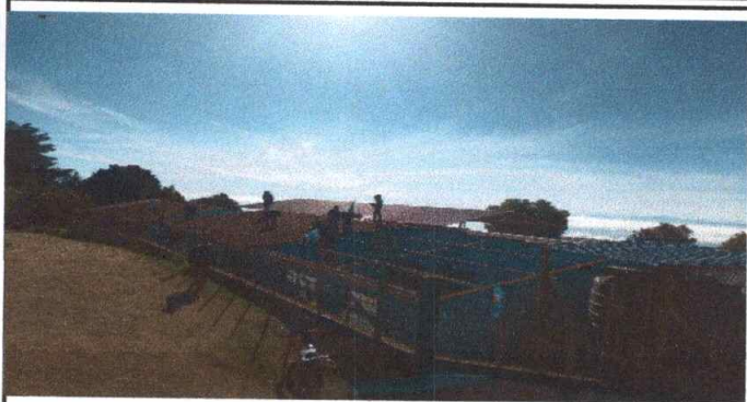
FOTO 1: SUSTITUCIÓN DE LAMINA POR LAMINA TROQUELADA
