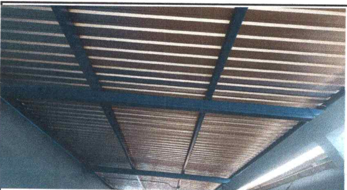
FOTO 3: SUSTITUCION DE ELEMENTOS DE FIJACION
