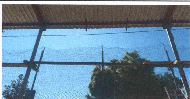
FOTO 11: SUSTITUCION DE CANAL PVC
