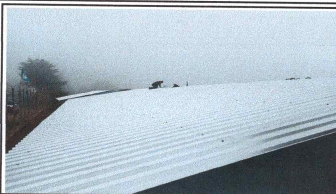
FOTO 2: SUSTITUCIÓN DE CAPOTE
