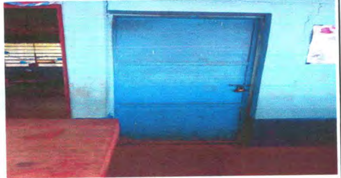
FOTO 8: PINTURA Y LIJADO DE FUERTA DE METAL
