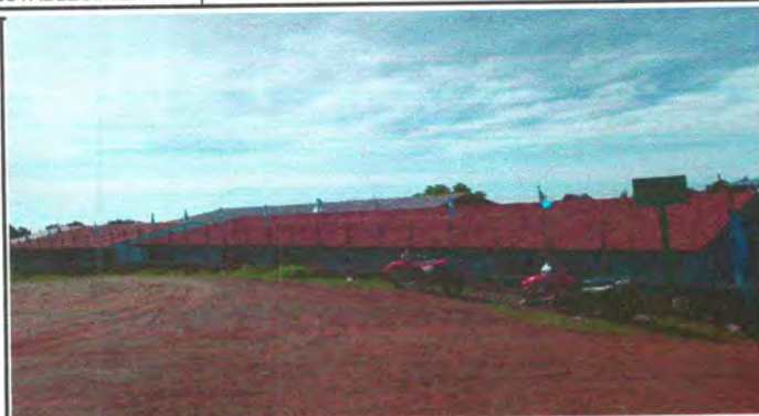
FOTO 1: SUSTITUCIÓN DE LAMINA POR LAMINA TROQUELADA
