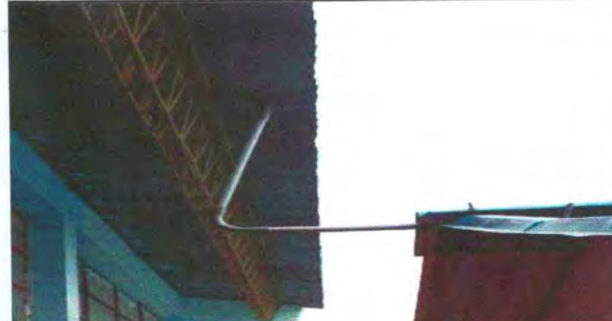
FOTO 4: MANTENIMIENTO A ESTRUCTURA DE SOPORTE DE METAL
