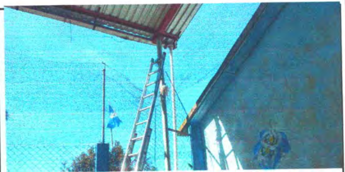
FOTO 12: SUSTITUCION DE BAJADAS DE AGUA
