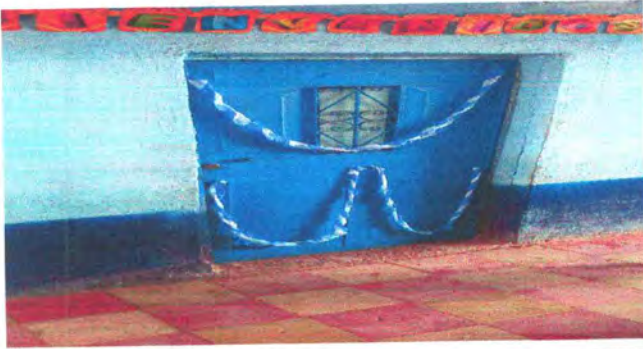
FOTO 7: REPARACION DE CHAPAS
