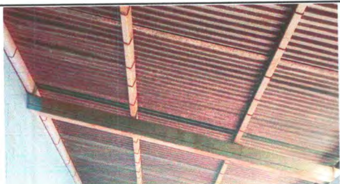
FOTO 3: SUSTITUCION DE ELEMENTOS DE FIJACION
