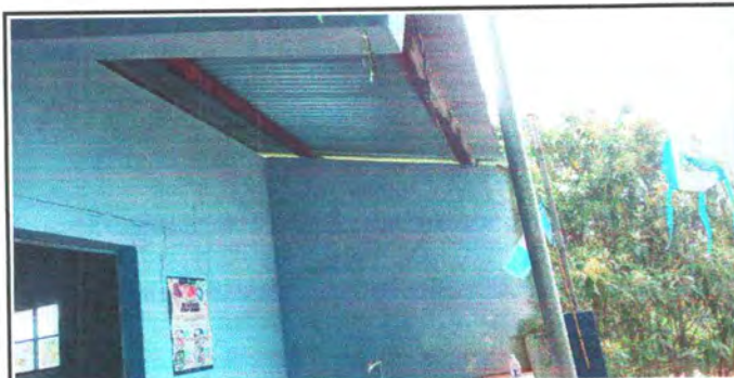
FOTO 5: SUSTITUCION DE ESTRUCTURA DE SOPORTE DE MADERA POR METAL
