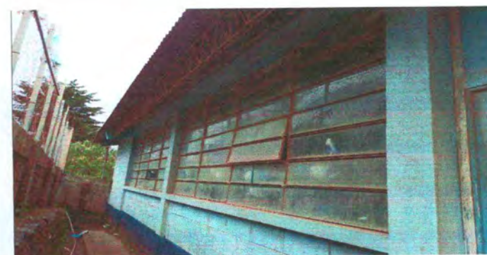
FOTO 6: SUSTITUCION DE ESTRUCTURA DE METAL DE VENTANA
