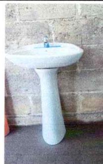
Foto 12: Sustitución de lavamanos
