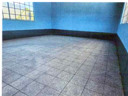
Foto 10: Sustitución de piso de cemento líquido
