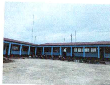
Foto 14: Pintura en muros exteriores e interiores
