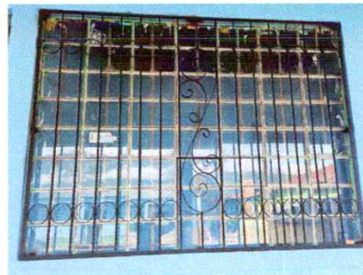
Foto 4: Sustitución de balcón de ventana
