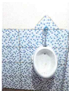
Foto 11: Sustitución de mingitorios
