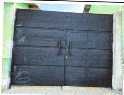
Foto 13: Sustitución de portón de metal de ingreso
