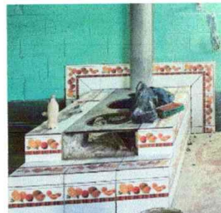
Foto 8: Sustitución de estufa rural completa
