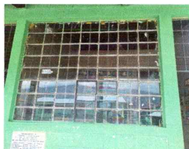
Foto 4: Sustitución de balcón de ventana
