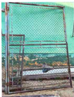
Foto 13 : Sustitución de portón de metal de ingreso
