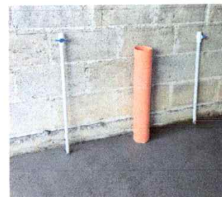
Foto 12: Sustitución de lavamanos
