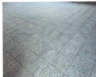
Foto 10: Sustitución de piso de cemento líquido
