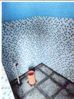
Foto1: Sustitución de inodoro
