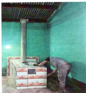
Foto 9: Sustitución de plancha de metal 3 hornillas
