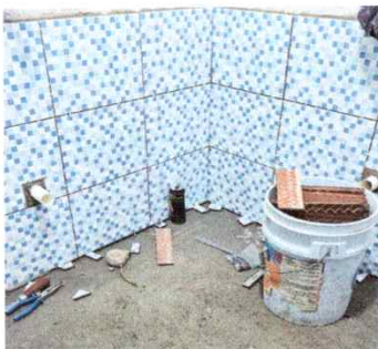
Foto 11: Sustitución de migitorios
