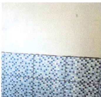
Foto 3: Repello y cernido de pared de baño
