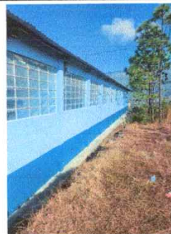
Foto 14: Pintura en muros exteriores e interiores
