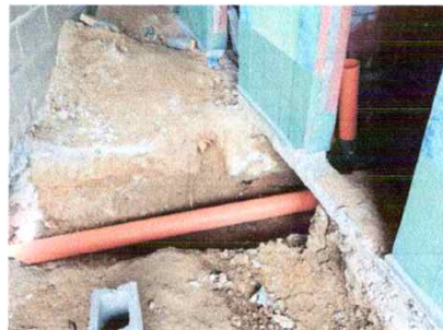
Foto 2: Sustitución de tubería PVC línea principal de aguas negras
