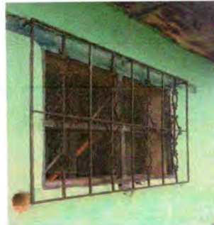
Foto 4: Sustitución de balcón de ventana
