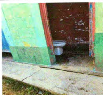
Foto 11: Sustitución de piso torta por cerámico
