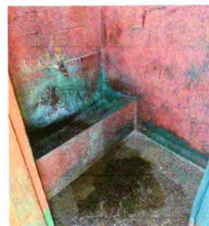
Foto 12: Sustitución de migitorios
