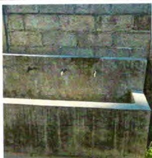
Foto 13: Sustitución de lavamanos
