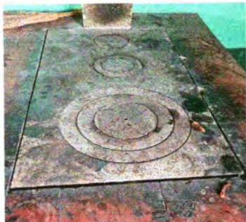
Foto 9: Sustitución de plancha de metal 3 hornillas
