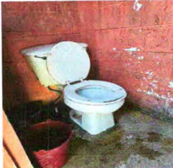
Foto1: Sustitución de inodoro
