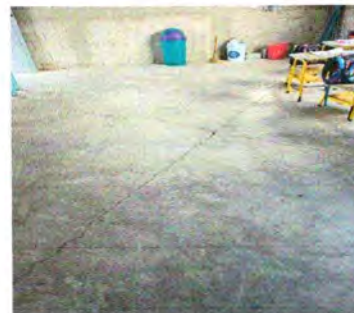
Foto 10: Sustitución de piso de cemento liquido
