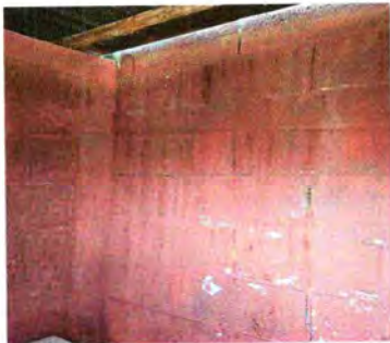
Foto 3: Repello y cernido de pared de baño
