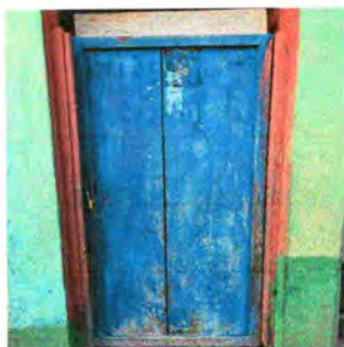
Foto7: Sustitución de puertas en servicios sanitarios
