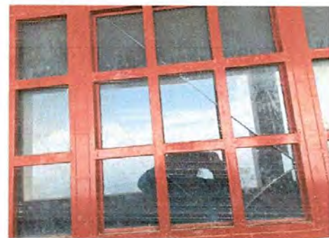
Foto 10: sustitución de vidrio
