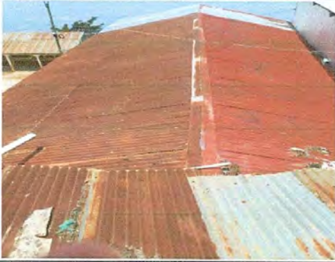
Foto1: Sustitución de lamina
