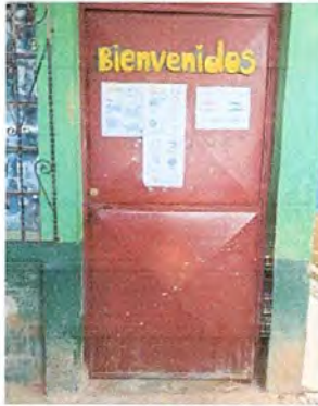
Foto 7: mantenimiento de puerta
