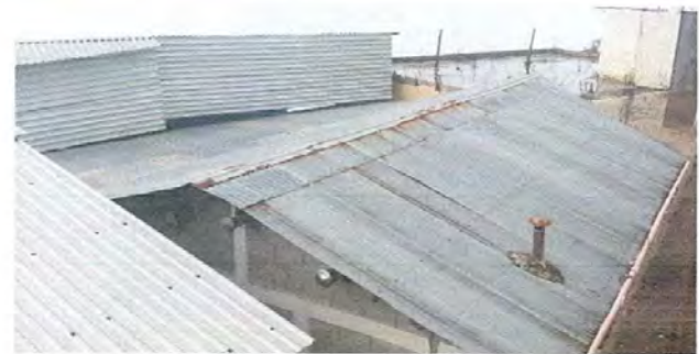
Foto 12: Sustitución de lamina cocina
