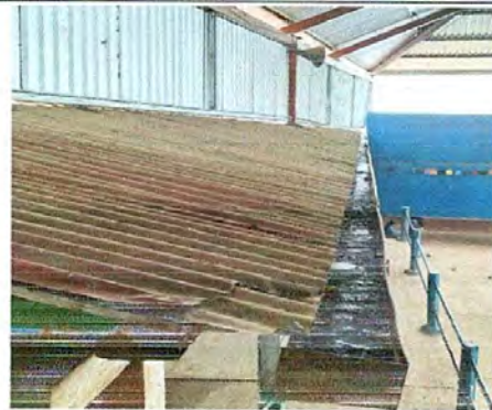
Foto 4: reparacion de bandeja de agua
