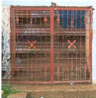
foto 9: mantenimiento de porton
