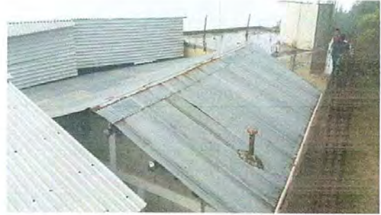
Foto 2: Sustitución de capote
