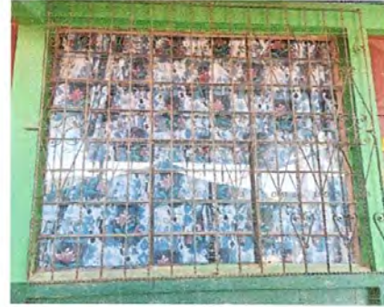
Foto 8: mantenimiento de balcon
