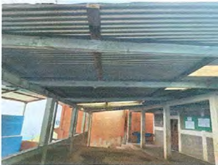
Foto 5: Sustitución de soporte de madera por metal
