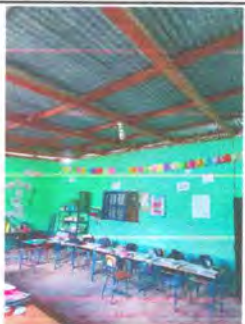
Foto13: Sustitución de lámparas tipo LED
