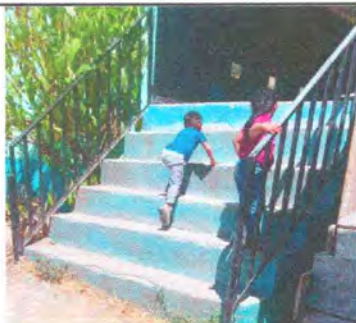
Foto 7: Sustrucción de gradas de concreto por gradas de concreto más rampa
