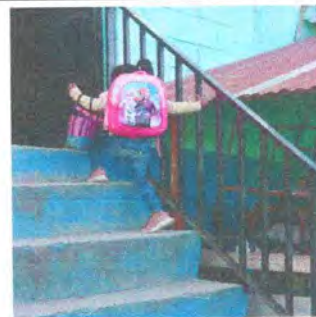
Foto 4: Sustitución de barandas de metal
