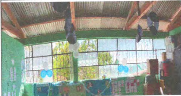
Foto1: Mantenimiento a estructura de metal de ventanas
