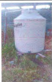
Foto 11: Sustrucción de depósito de agua 2500 lt
