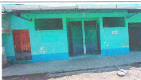
Foto 10: Pintura en muros exteriores e interiores (Baños)
