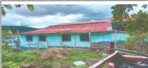
Foto 8: Sustrucción de láminas, por lámina troquelada aluzinc calibre 26
