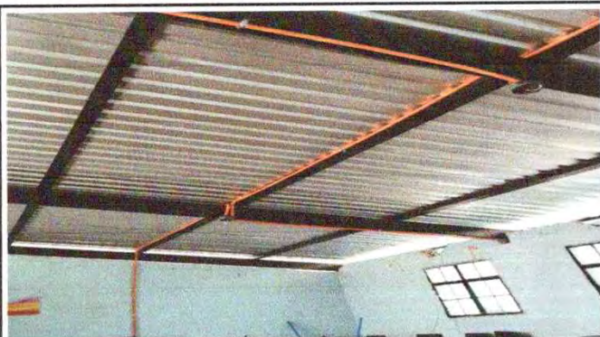
Foto 15: Sustitución de focos ahorradores
