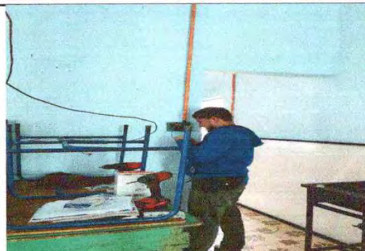
Foto 24: Sustitución de tomacorrientes dobles.
