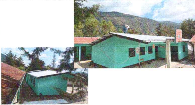
Foto 1: Sustitución de lámina, por lámina troquedala aluzinc calibre 26
