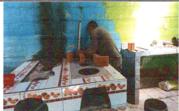
Foto 24: Sustitución de chimenea de concreto
