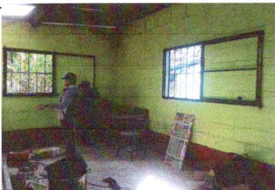
Foto 9: Sustitución de ventana de madera por metal más vidrio
