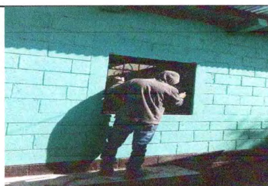
Foto 10: Mejoramiento de balcones de metal.
