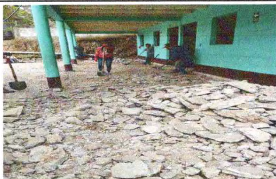
Foto 11: Sustitución de torta de concreto por piso granito
