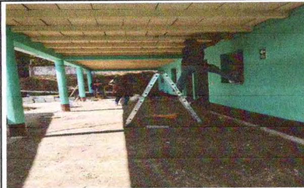
Foto 16: Sustitución de plafoneras
