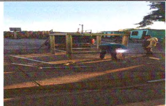
Foto 22: Mejoramiento de base para depósito de almacenamiento de agua
