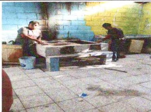
Foto 23: Sustitución de plancha de metal de 3 hornillas
