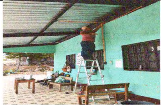
Foto 20: Sustitución de ducto eléctrico más accesorios
