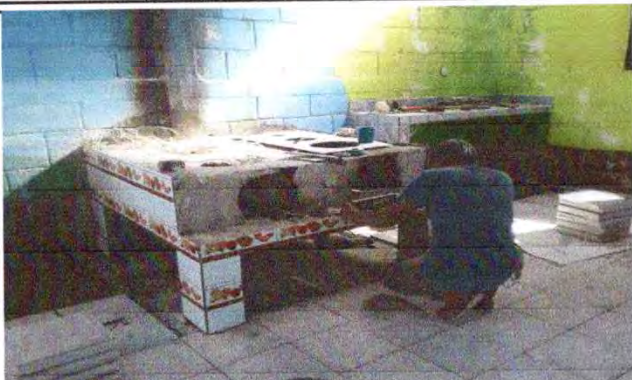
Foto 25: Instalación de azulejo en estufa rural.
