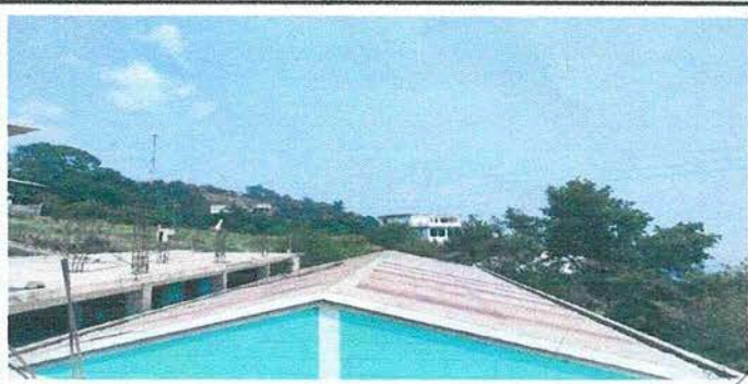
SUSTITUCIÓN DE LAMINA Y CAPOTES
