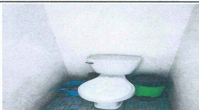
REPARACIÓN Y MANTENIMIENTO DE AZULEJO (SERVICIO SANITARIO)
