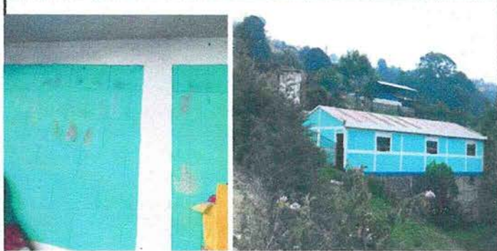
PINTURA EN MUROS INTERIORES Y EXTERIORES
