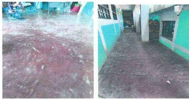
SUSTITUCION DE PISO DE TORTA DE CONCRETO.
