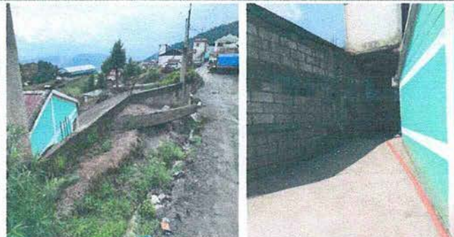
REPARACION DE MURO DE CONTENCIÓN (ampliación)
