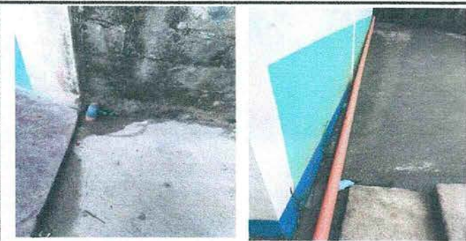
SUSTITUCIÓN DEL CANAL PVC
