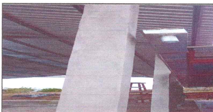
Foto 5: Sustrucción de soporte o pescante de metal para canal y canales de bajadas de agua pluvial
