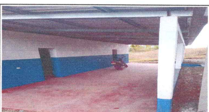
Foto 6: Pintura de paredes interiores y exteriores
