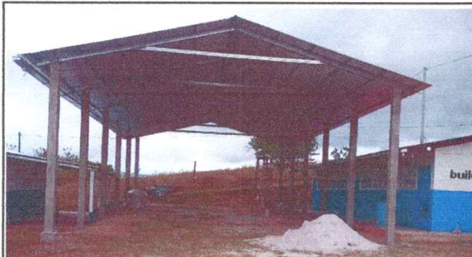
Foto 1: Sustrucción de lámina en el patio, por lámina troquelada aluzink calibre 26
