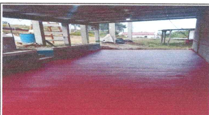
Foto 4: Sustrucción de piso de torta de concreto a cemento líquido en corredor de dirección
