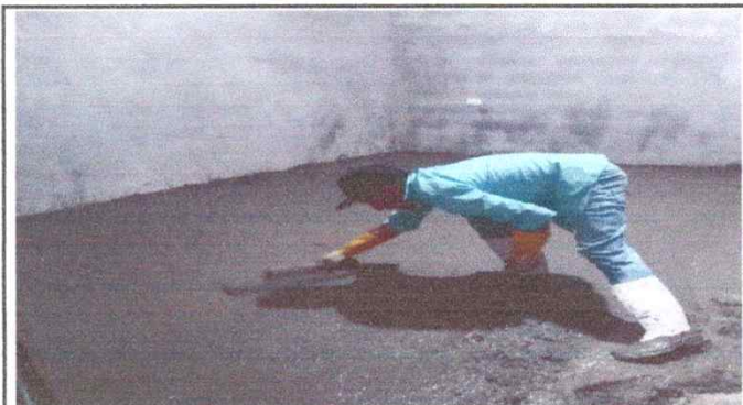
Foto 3: Sustitución de piso de torta de concreto a cemento líquido en dirección
