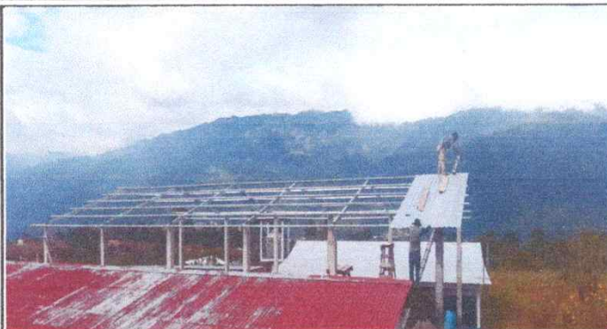
Foto 1: Sustitución de lámina en el patio, por lámina troquelada aluzink calibre 26.
