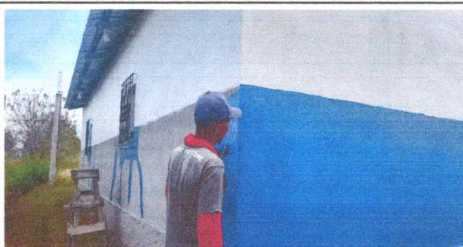
Foto 6: Pintura de paredes interiores y exteriores
