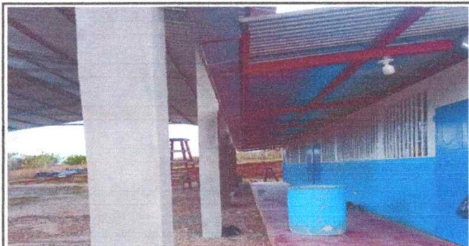
Foto 5: Sustitución de soporte o pescante de metal para canal y canales de bajadas de agua pluvial
