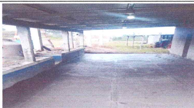
Foto 4: Sustitución de piso de torta de concreto a cemento líquido en corredor de dirección
