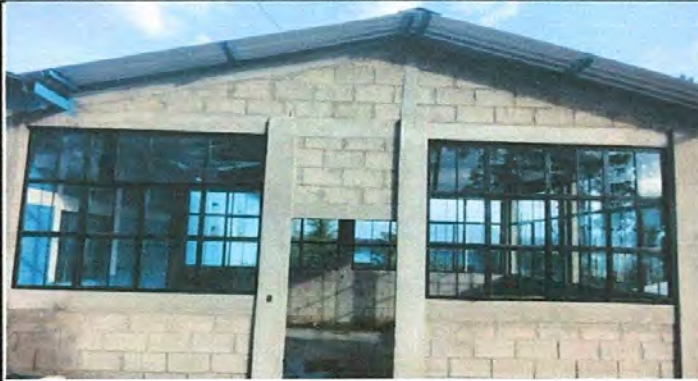
Foto1: Reforzamiento de paredes en muro de cocina
