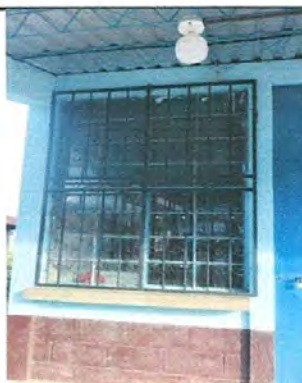
Foto 4: Instalacion de balcones en ventanas
