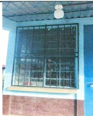
Foto 4: Instalacion de balcones en ventanas
