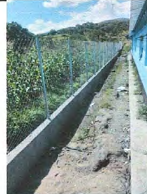
Foto 2: Repello en paredes de muro perimetral
