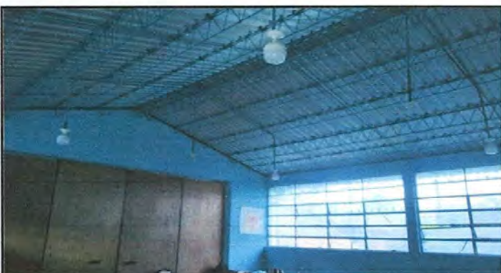
Foto 3: Instalacion de sistema electrico
