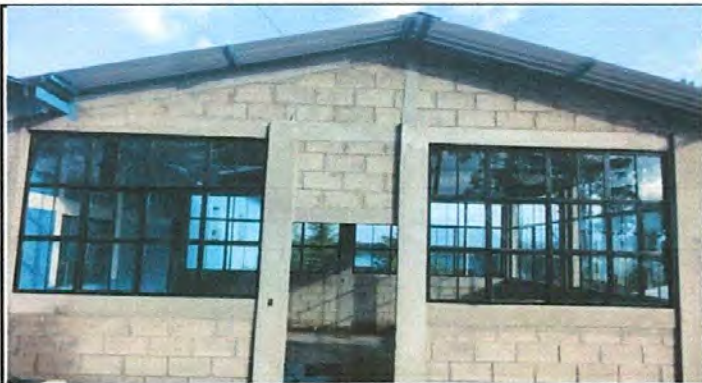
Foto1: Reforzamiento de paredes en muro de cocina
