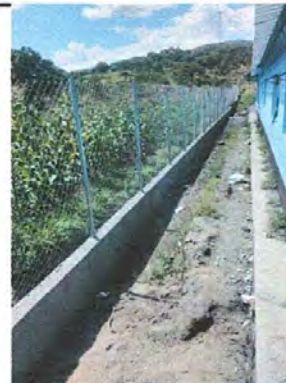
Foto 2: Repello en paredes de muro perimetral
