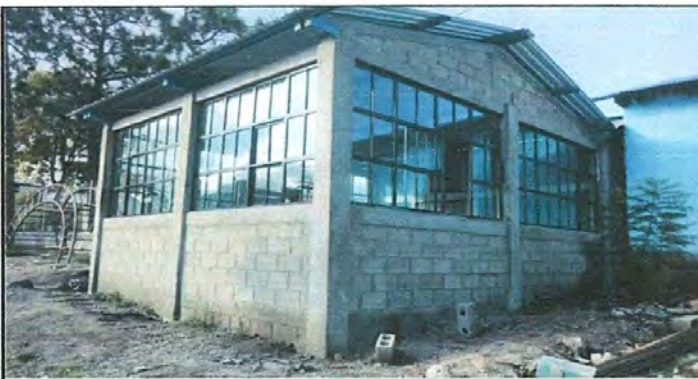
Foto 5: Instalacion de Ventanas
