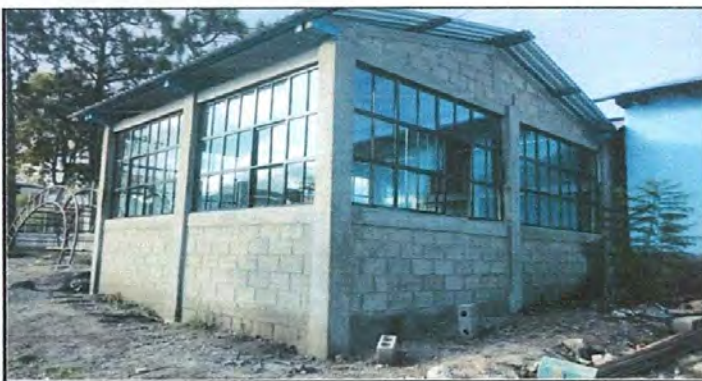
Foto 5: Instalacion de Ventanas
