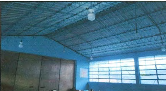
Foto 3: Instalacion de sistema electrico
