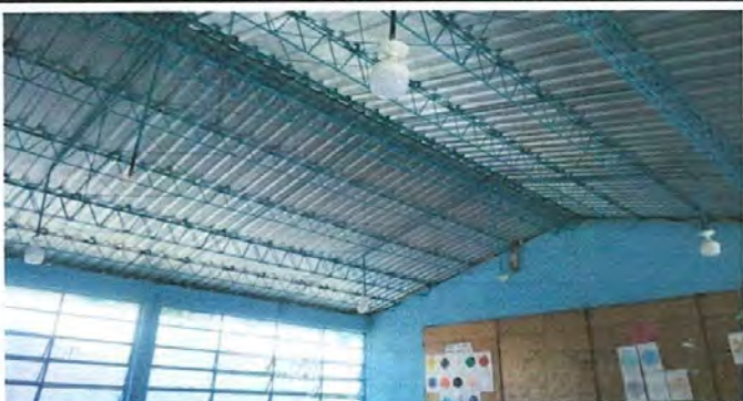
Foto 3: Instalacion de sistema electrico
