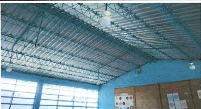
Foto 3: Instalacion de sistema eléctrico
