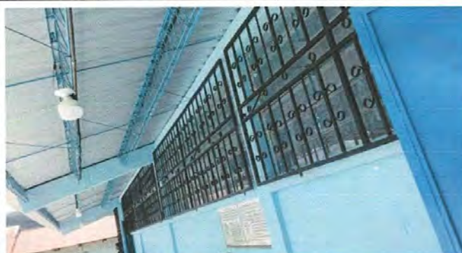
Foto 4: Instalacion de valcones en ventanas
