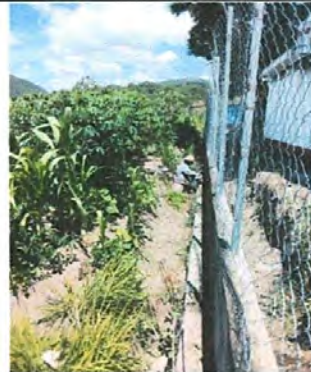
Foto 2: Repello en paredes de muro
