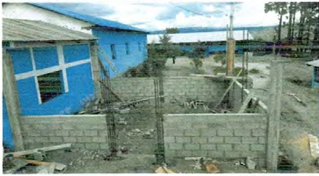
Foto 1: Reforzamiento en paredes de muro de cocina
