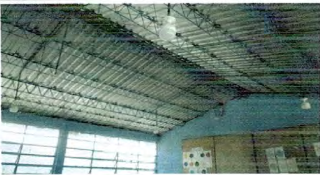
Foto 3: Instalacion de sistema electrico
