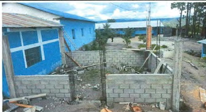
Foto 1: Reforzamiento en paredes de muro de cocina
