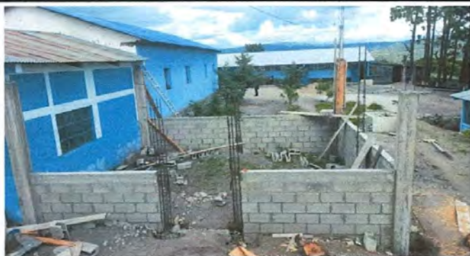
Foto 1: Reforzamiento en paredes de muro de cocina
