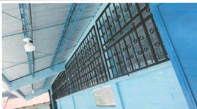
Foto 4: Instalacion de valcones en ventanas
