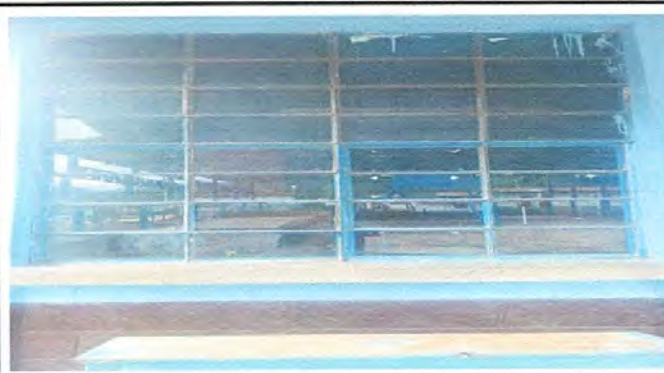
Foto 4: Ventanas sin balcones
