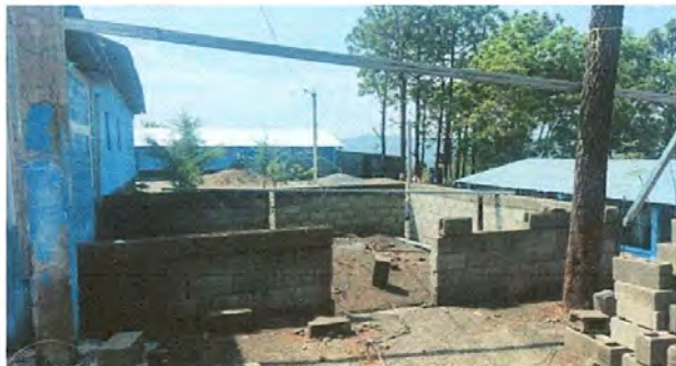
Foto 1: Reforzamiento de paredes en muros de cocina
