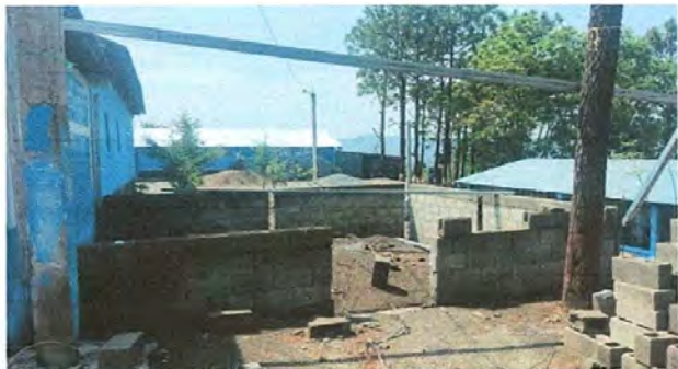
Foto 1: Reforzamiento de paredes en muros de cocina
