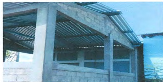
Foto 5: Cocina sin ventanas
