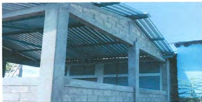
Foto 5: Cocina sin ventanas
