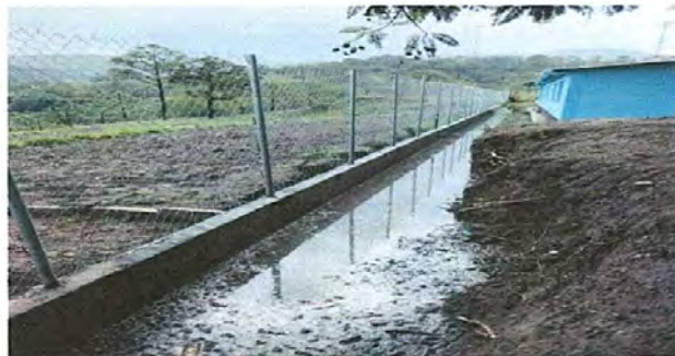
Foto 2: Repello en paredes de Muro
