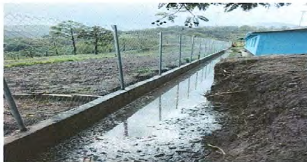
Foto 2: Repello en paredes de Muro
