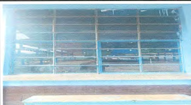
Foto 4: Ventanas sin balcones
