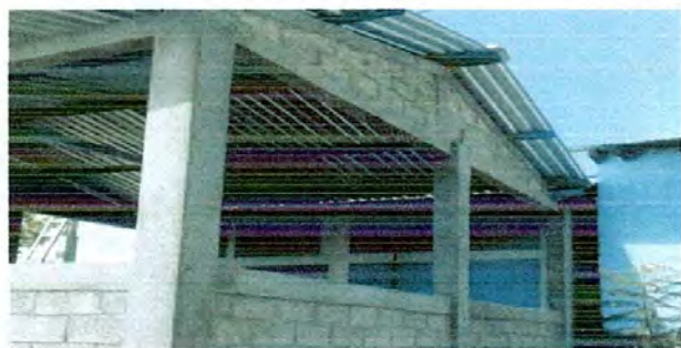
Foto 5: Cocina sin ventanas
