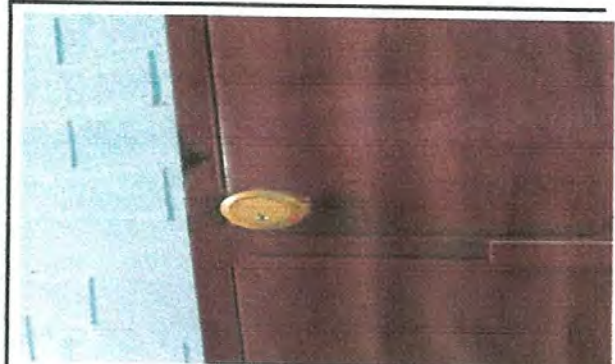
Foto 10: Sustrucción de chapas
