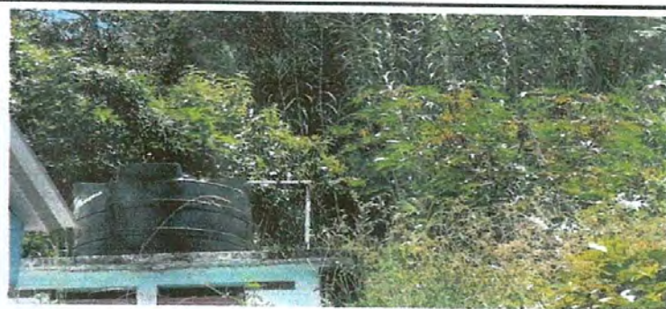
Foto 6: Sustitución de depósito de Agua
