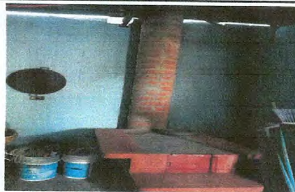
Foto 3: Sustitución de estufa rural (completa)
