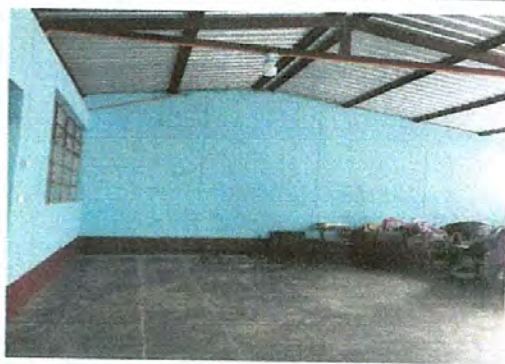
Foto 9: Pintura en muros exteriores e interiores
