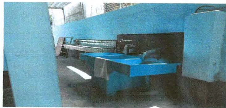
Foto 2: Sustitución de 2 pilas de cemento de 2 lavaderos
