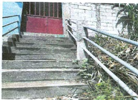
Foto 11: Mejoramiento de gradas de ingreso
