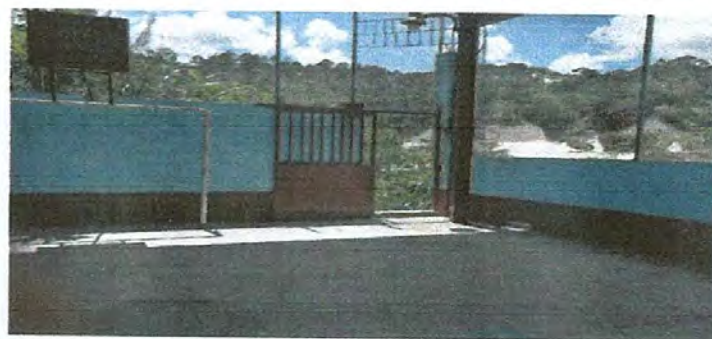
Foto 4: Sustitución de portón de metal
