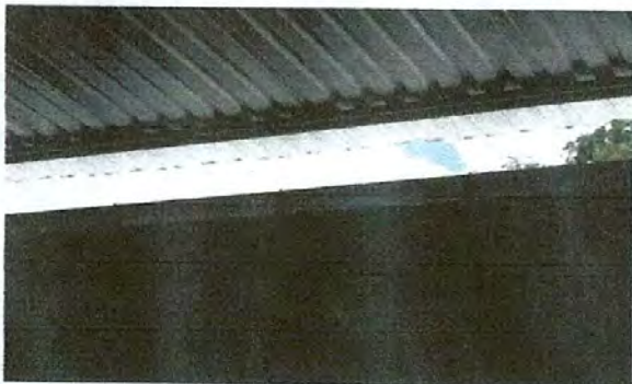
Foto 1: Sustitución de Canal de agua de metal
