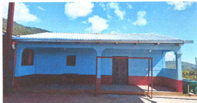
Foto1: Sustitución de lamina a lamina troquelada trabajo finalizado el 100%
