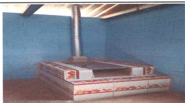
Foto 3: Sustitución de estufa rural e instalación de azulejo a estufa rural trabajo finalizado el 100%
