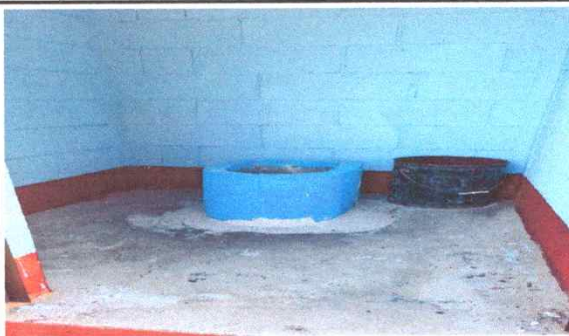
Foto 6: Sustitución de letrinas trabajo finalizado el 100%
