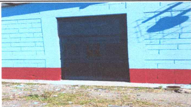
Foto 7: Sustrucción de puertas de metal trabajo finalizado el 100%
