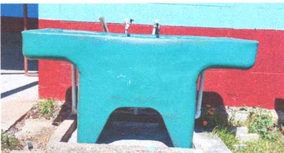
Foto 4: Sustitución de pila plastica de dos lavaderos trabajo finalizado el 100%
