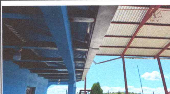
Foto 10: Sustrucción canal de metal de la cocina trabajo finalizado el 100%
