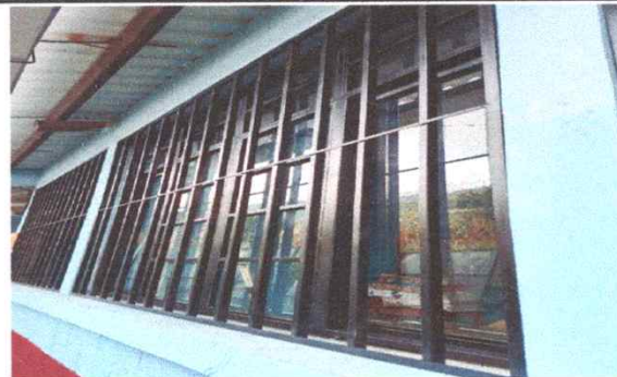
Foto 8: Sustrucción de estructura de metal de ventana trabajo finalizado el 100%
