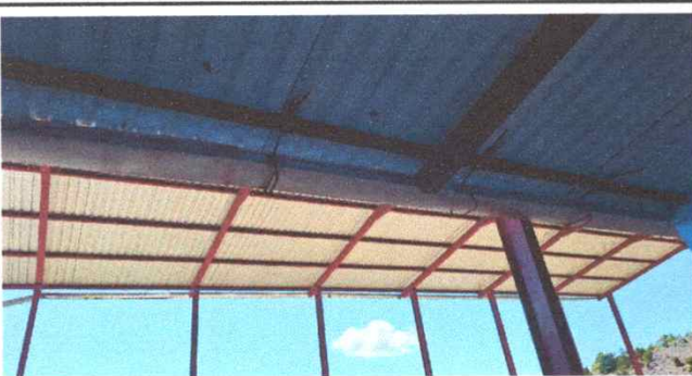
Foto 9: Sustrucción de canal de metal de la escuela trabajo finalizado el 100%
