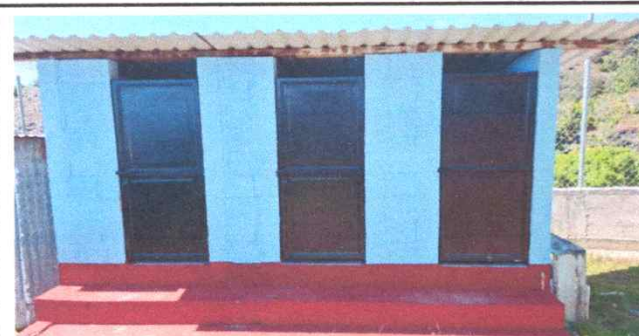
Foto 5: Cambio de puertas e instalación trabajo finalizado el 100%
