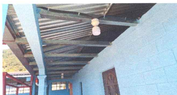
Foto 2: Sustitución de estructura de soporte de madera por metal trabajo finalizado el 100%
