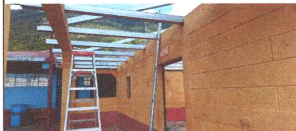
Foto 2: Sustrucción de estructura de soporte de madera por metal trabajo a un avance del 50%
