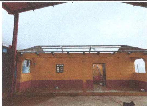
Foto 1: Sustrucción de lamina a lamina troquelada trabajo a un avance del 50%
