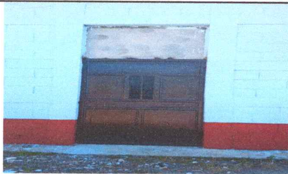
Foto 7: Sustrucción de puerta de metal avance a un 50%
