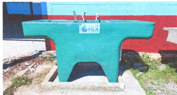
Foto 4: Sustrucción de pila plastica de dos lavaderos a un avance del 50%
