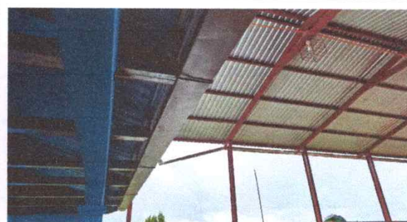
Foto 10: Sustrucción canal de metal de la cocina a un avance de trabajo del 50%
