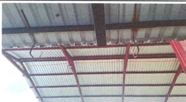
Foto 9: Sustrucción de canal de metal de la escuela a un avance de trabajo del 50%
