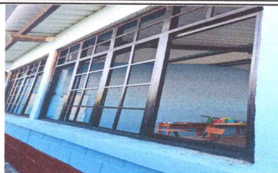
Foto 8: Sustrucción de estructura de metal de ventana a un avance de trabajo del 50%
