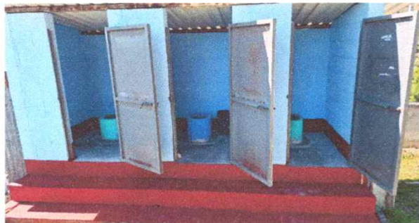
Foto 5: Cambio de puertas e instalación avance a 50%
