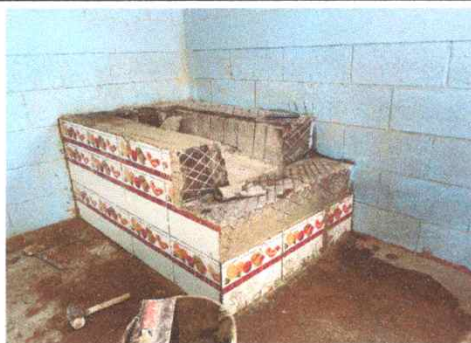
Foto 3: Sustrucción de estufa rural e instalación de azulejo a estufa rural a un avance del 50%
