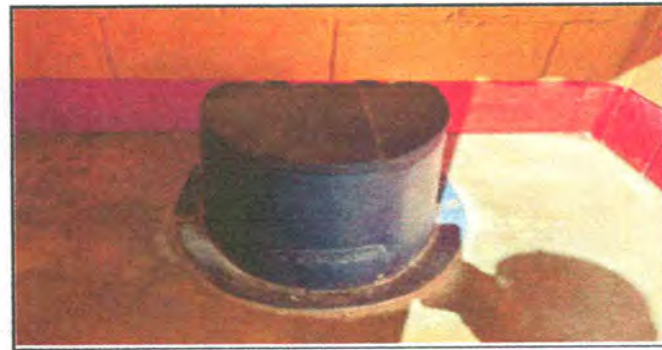
Foto 6: Sustitucion de inodoro
