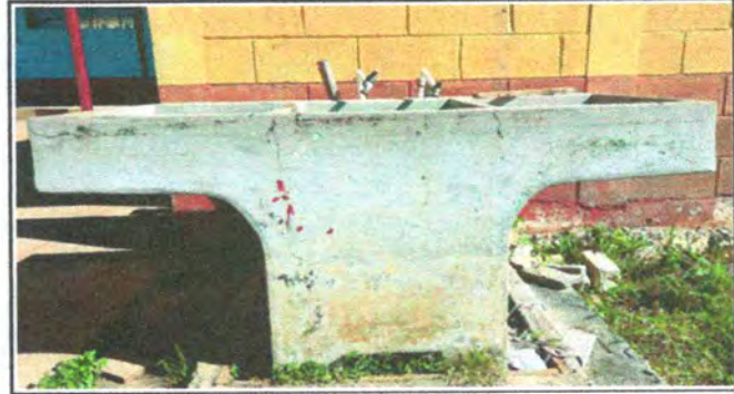
Foto 4: Sustitución de pila plastica de dos lavaderos
