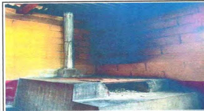
Foto 3: Sustitución de estufa rural e instalacion de azulejo a estufa rural
