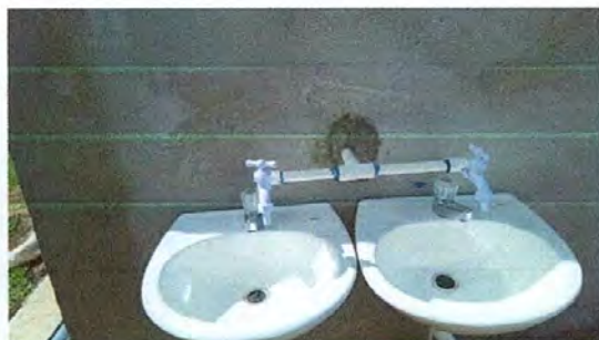
FOTO 1: sustitución de lavamanos
