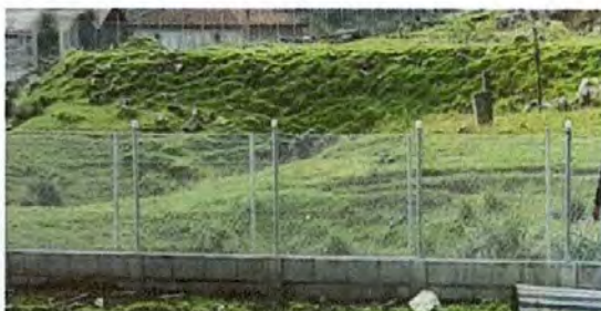
FOTO 7: Instalaciones de estructuras portantes de metal
