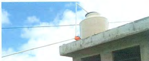
FOTO 5: Sustitución de bomba de agua
