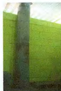
FOTO 6: sustitución de chimenea de lata por chimenea de concreto
