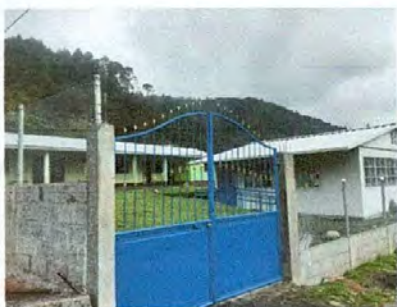
FOTO 3: fabricación e instalación de portón
