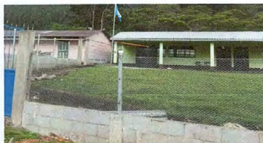
FOTO 2: reparación de tubo, maya perimetral y continuación de circulación.
