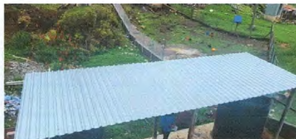
FOTO 8: Sustitución de lamina del techo de tinacos para agua potable, necesaria para cosecha de agua para centro educativo
