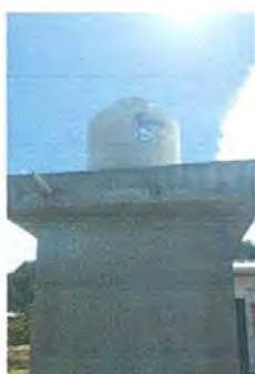
FOTO 5: Sustitución de bomba de agua
