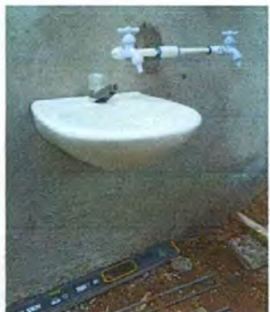
FOTO 1: sustitución de lavamanos
