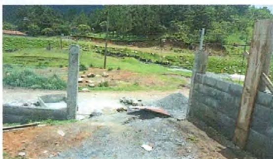
FOTO 3: fabricación e instalación de portón
