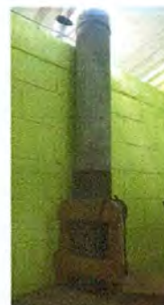
FOTO 6: sustitución de chimenea de lata por chimenea de concreto
