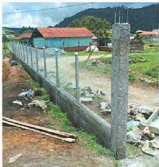
FOTO 7: Instalaciones de estructuras portantes de metal
