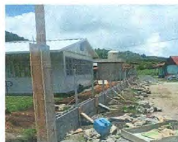
FOTO 2: reparación de tubo, maya perimetral y continuación de circulación.
