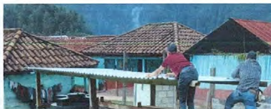
FOTO 8: Sustitución de lamina del techo de tinacos para agua potable, necesaria para cosecha de agua para centro educativo
