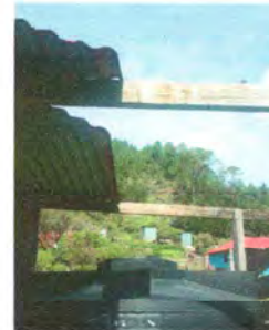
FOTO 4: sustrución de lamina del techo de tinacos para agua pontable, necesaria para cosecha de agua para el centro educativo
