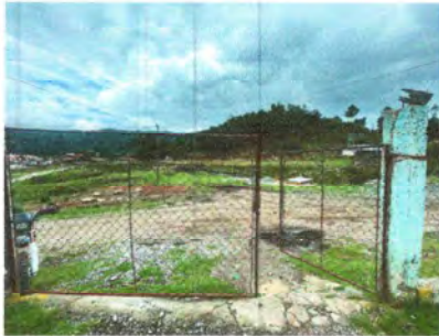
FOTO 1: Sustrución de portón
