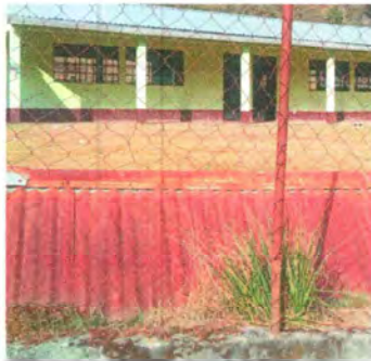
FOTO 3: reparación de tubo perimetral
