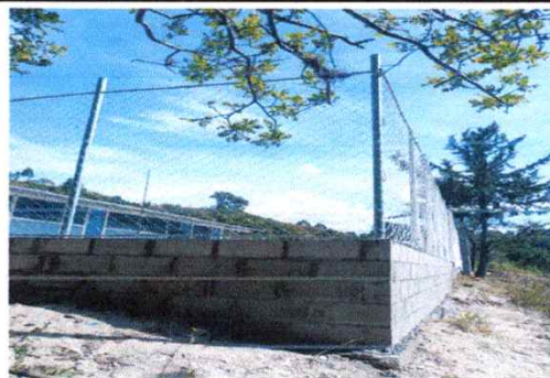
Foto 8: Reparacion de muro perimetral con tuvo HG y malla Galvanizada
