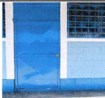
Foto 4: Mantenimiento de estructura (lijado y pintado)de 11 puertas
