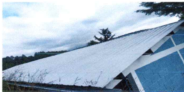
Foto 2: Mantenimiento de techo de lamina (lijado y Pintado)
