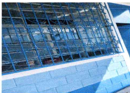
Foto 5: Sustitución de vidrios
