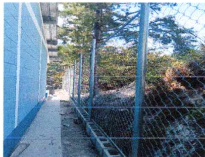
Foto 9: Reparacion de muro perimetral con tuvo HG y malla Galvanizada
