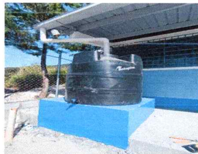
Foto 10: Sustitucion de deposito de agua de 1,700 litros
