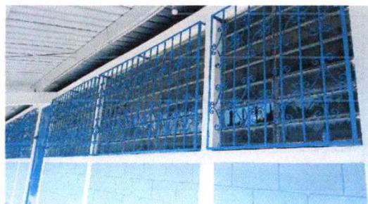
Foto 6: mantenimiento a balcones de metal
