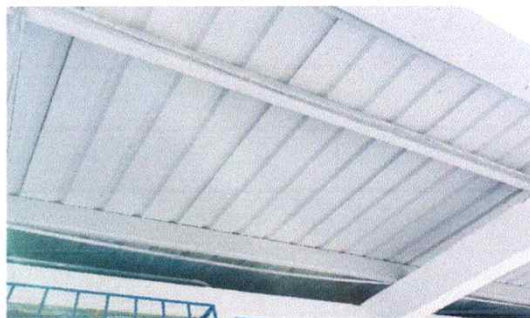
Foto1: Mantenimiento estructura soporte de metal
