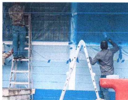
Foto 6: mantenimiento a balcones de metal
