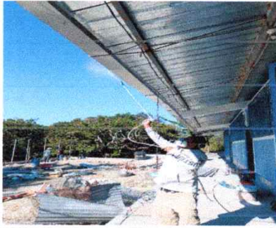
Foto7: Pintura en muros y pared exteriores e interior
