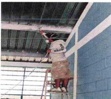
Foto1: Mantenimiento estructura soporte de metal
