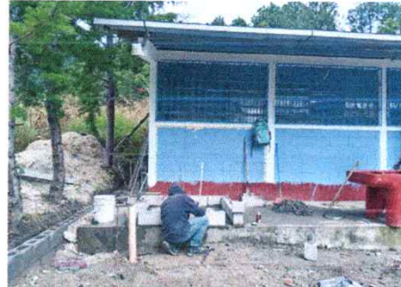
Foto 10: Sustitucion de deposito de agua de 1,700 litros
