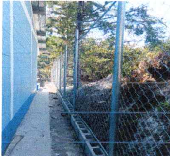
Foto 9: Reparacion de muro perimetral con tuvo HG y malla Galvanizada
