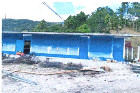
Foto 4: Mantenimiento de estructura (lijado y pintado)de 11 puertas
