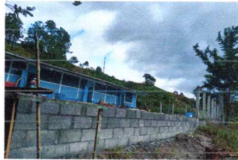
Foto 8: Reparacion de muro perimetral con tuvo HG y malla Galvanizada
