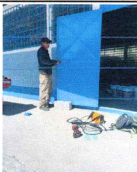
Foto 3: Sustitucion de 7 chapas
