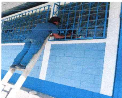
Foto 5: Sustitución de vidrios
