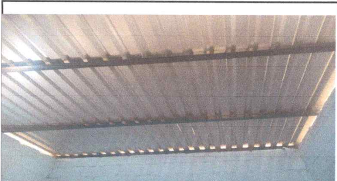
Foto 3: Sustitución de estructura del techado de madera por metal
