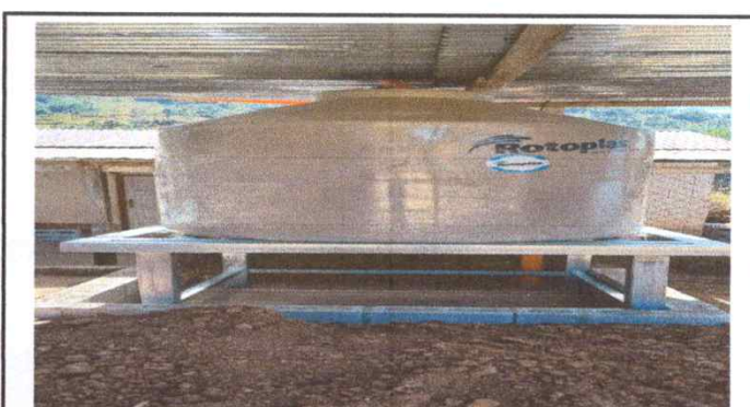
Foto 6: Sustitución de depósito de agua de barril por tinaco
