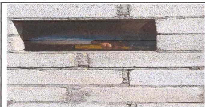
Foto 5: Sustitución de ventana de madera por metal
