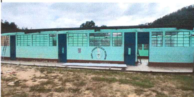
Foto1: Sustitución de lámina por lamina tioquelada aluzinc calibre 26
