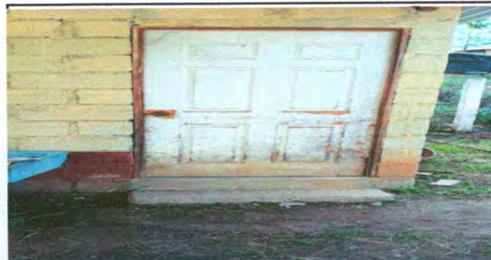
Foto 4: Sustrucción de puerta de madera por metal
