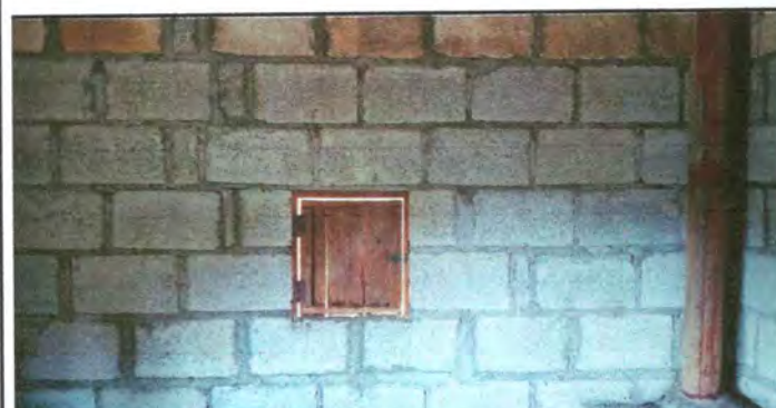
Foto 5: Sustrucción de ventana de madera por metal
