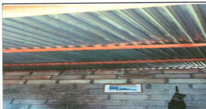
Foto 3: Sustrucción de estructura del techado de madera por metal
