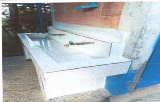
FOTO 6: MANTENIMIENTO DE LAVAMANOS MULTIPLES
