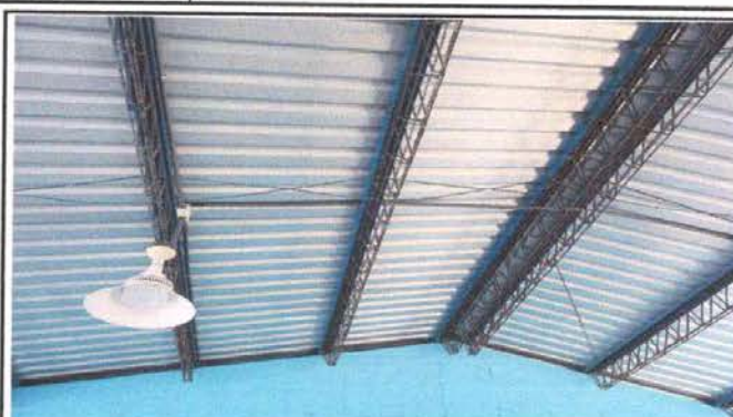
FOTO 20: SUSTITUCION DE DUCTO ELECTRICO +ACCESORIOS
