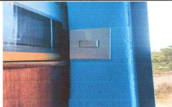
FOTO 14: SUSTITUCION DE INTERRUPTORES SIMPLES (AULAS)
