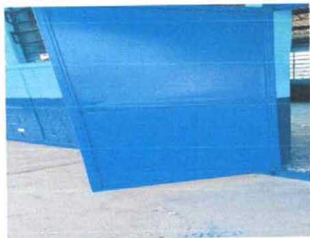
FOTO 5: MANTENIMIENTO DE PUERTAS DE METAL; LIJADO Y PINTURA
