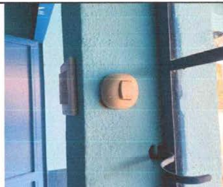
FOTO 16: SUSTITUCION DE PULSADOR DE TIMBRE
