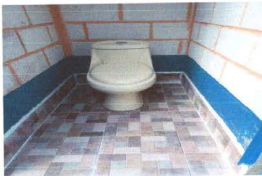
FOTO 4: SUSTITUCION DE INODOROS
