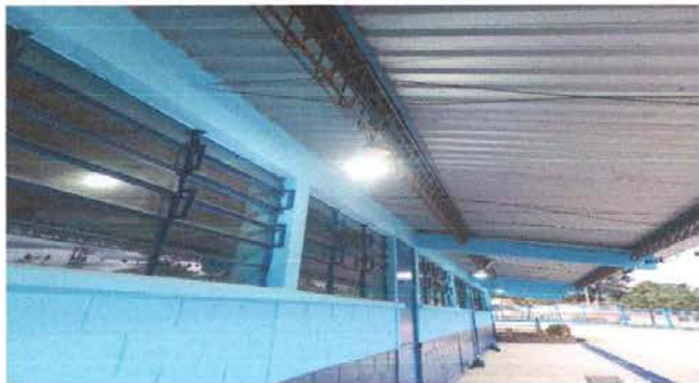
FOTO 13: SUSTITUCION DE PLAFONERAS (CORREDOR)
