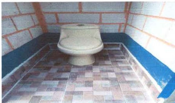
FOTO 10: SUSTITUCION DE PISO TORTA DE CEMENTO POR PISO DE MOSAICO ANTIDESLIZANTE EN BAÑOS
