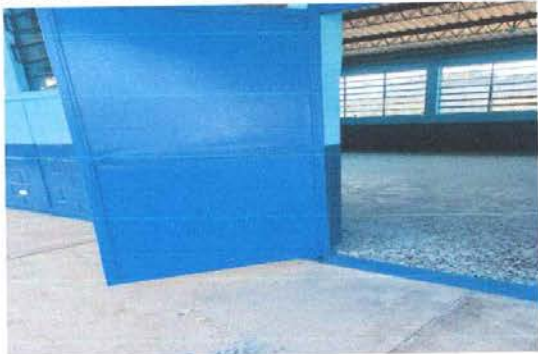
FOTO 1: SUSTITUCION DE PISO DE TORTA DE CEMENTO POR PISO DE GRANITO
