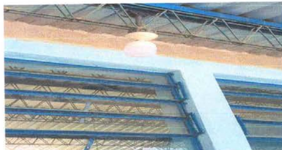
FOTO 2: SUSTITUCIÓN DE CABLEADO ELECTRICO
