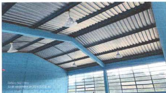
FOTO 11: SUSTITUCION DE LAMPARAS DE AULAS
