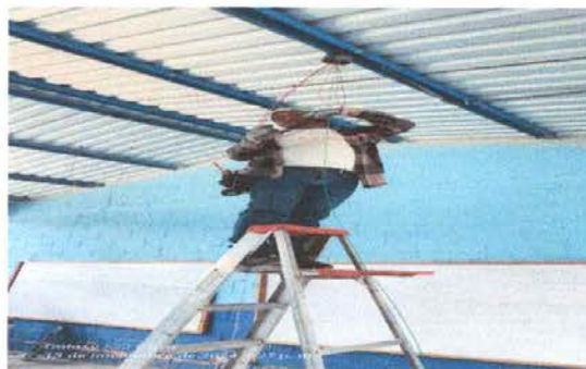
FOTO 20: SUSTITUCION DE DUCTO ELECTRICO +ACCESORIOS
