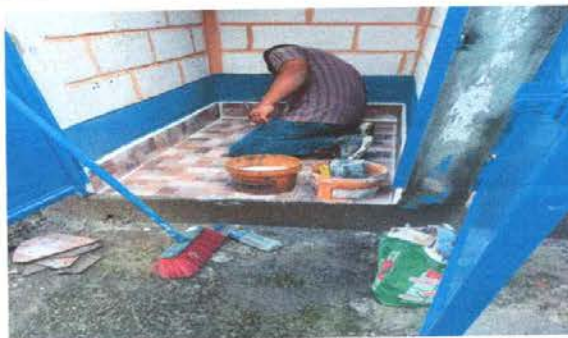
FOTO 10: SUSTITUCION DE PISO TORTA DE CEMENTO POR PISO DE MOSAICO ANTIDESLIZANTE EN BAÑOS
