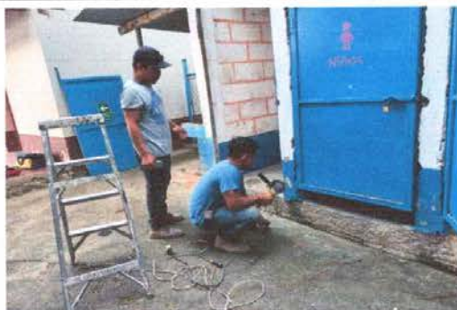
FOTO 3: SUSTITUCION DE PUERTAS DE METAL DE LOS BAÑOS
