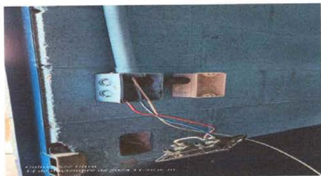
FOTO 15: SUSTITUCION DE INTERRUPTORES DOBLES
