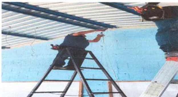
FOTO 19: SUSTITUCION DE CABLEADO ELECTRICO EN EL EDIFICIO ESCOLAR
