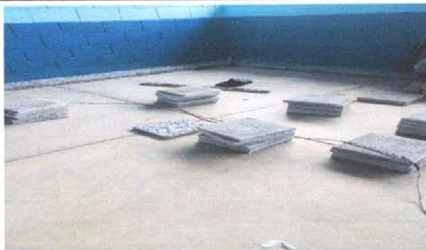
FOTO 1: SUSTITUCION DE PISO DE TORTA DE CEMENTO POR PISO DE GRANITO
