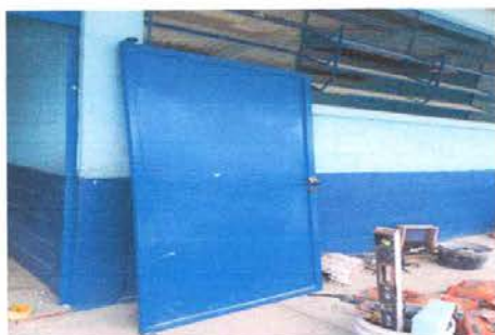
FOTO 5: MANTENIMIENTO DE PUERTAS DE METAL; LIJADO Y PINTURA
