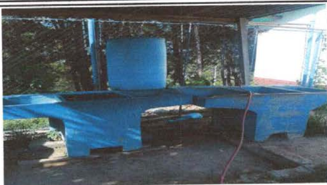
FOTO 7: SUSTITUCION DE PILAS PARA LAVADO DE MANOS Y 1 PARA USO DE COCINA EN LA PREPARACION DE ALIMENTOS
