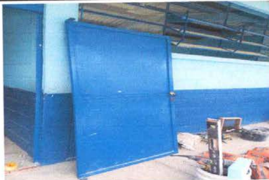
FOTO 8: MANTENIMIENTO DE PUERTAS DE METAL (DESINSTALACION, MODIFICACION DE MEDIDAS, PINTURA E INSTALACION)
