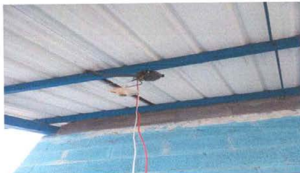
FOTO 13: SUSTITUCION DE PLAFONERAS (CORREDOR)
