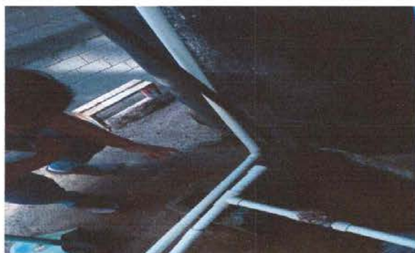
FOTO21: SUSTITUCION DE DEPOSITO DE AGUA DE 1,700 LT
