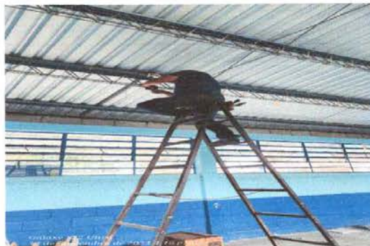
FOTO 2: SUSTITUCIÓN DE CABLEADO ELECTRICO
