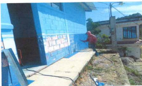
FOTO 9: PINTURA INTERIONES Y EXTERIORES
