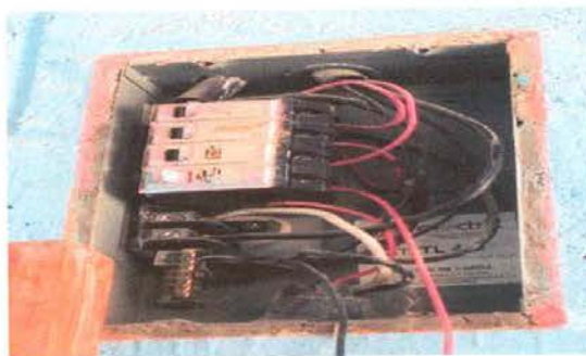
FOTO 18: SUSTITUCION DE LIPONES EDIFICIO ESCOLAR
