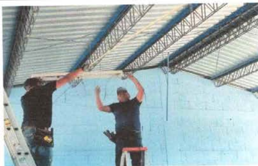
FOTO 11: SUSTITUCION DE LAMPARAS DE AULAS
