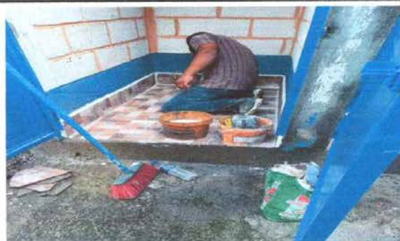
FOTO 4: SUSTITUCION DE INODOROS
