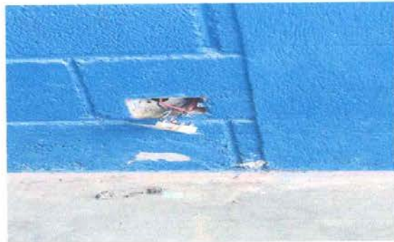
FOTO 14: SUSTITUCION DE INTERRUPTORES SIMPLES (AULAS)
