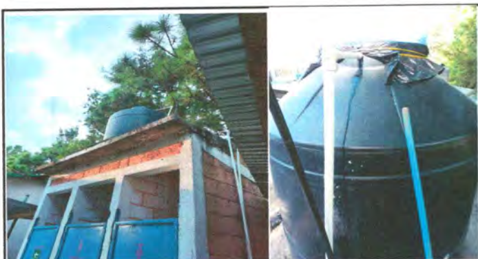
FOTO21: SUSTITUCION DE DEPOSITO DE AGUA DE 1,700 LT
