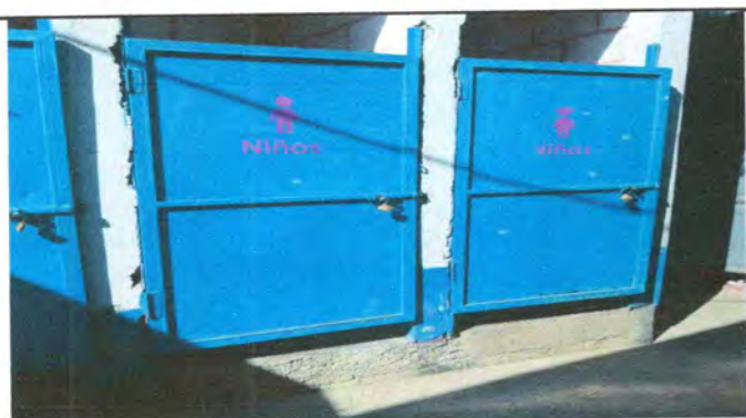
FOTO 3: SUSTITUCION DE PUERTAS DE METAL DE LOS BAÑOS
