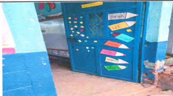
FOTO 8: MANTENIMIENTO DE PUERTAS DE METAL (DESINSTALACION, MODIFICACION DE MEDIDAS, PINTURA E INSTALACION)
