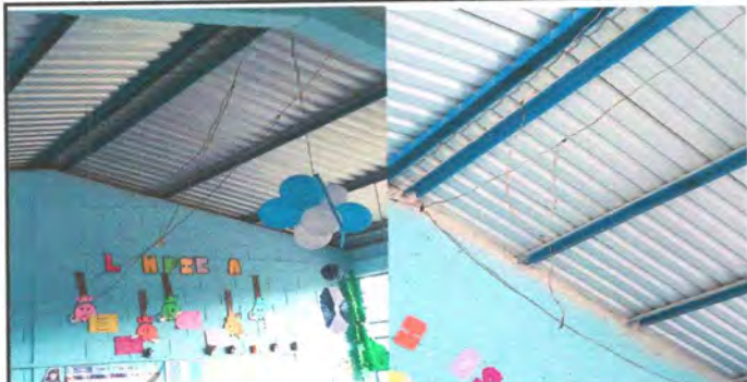
FOTO 19: SUSTITUCION DE CABLEADO ELECTRICO EN EL EDIFICIO ESCOLAR
