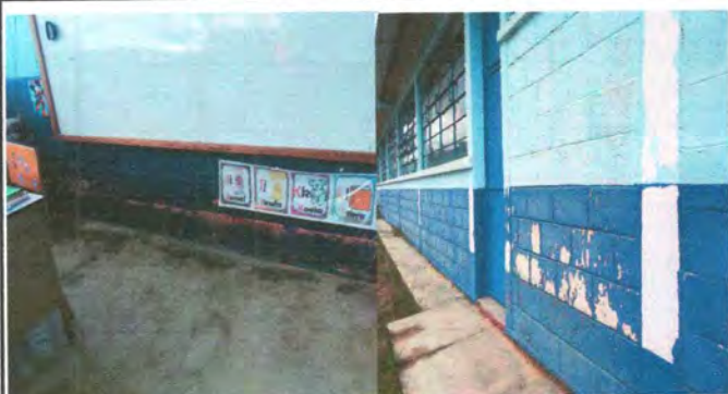
FOTO 9: PINTURA INTERIORES Y EXTERIORES
