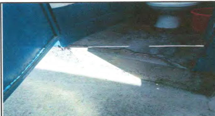
FOTO 10: SUSTITUCION DE PISO TORTA DE CEMENTO POR PISO DE MOSAICO ANTIDESLIZANTE EN BAÑOS
