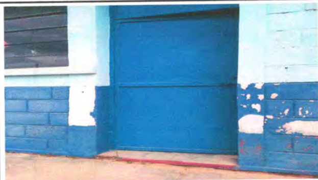
FOTO 5: MANTENIMIENTO DE PUERTAS DE METAL; LIJADO Y PINTURA
