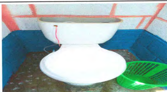
FOTO 4: SUSTITUCION DE INODOROS
