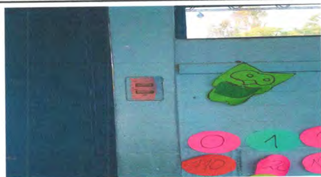
FOTO 15: SUSTITUCION DE INTERRUPTORES DOBLES
