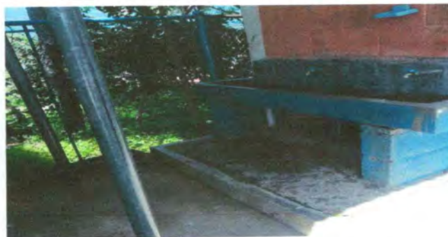
FOTO 6: MANTENIMIENTO DE LAVAMANOS MULTIPLES
