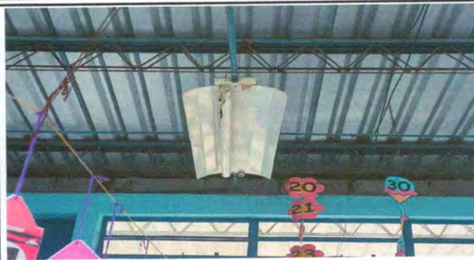
FOTO 2: SUSTITUCIÓN DE CABLEADO ELECTRICO
