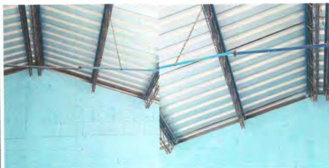
FOTO 20: SUSTITUCION DE DUCTO ELECTRICO +ACCESORIOS
