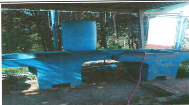
FOTO 7: SUSTITUCION DE PILAS PARA LAVADO DE MANOS Y 1 PARA USO DE COCINA EN LA PREPARACION DE ALIMENTOS
