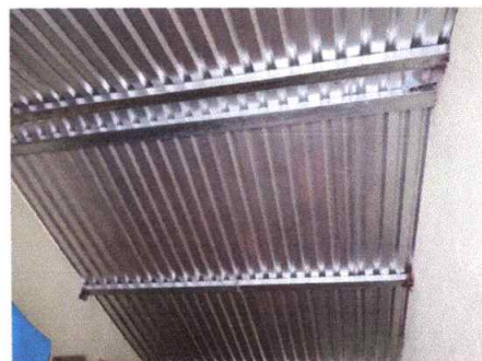
Foto 4: sustitución de estructura de soporte de madera de metal
