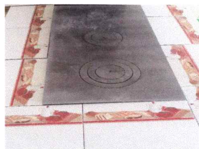
Foto 6: Sustrucción de plancha de 3 hornillas
