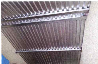
Foto1: sustitución de lamina por lámina troquelada aluzinc calibre 26
