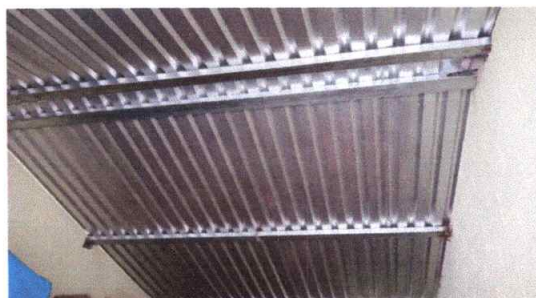
Foto 3: sustitución de elementos de fijación
