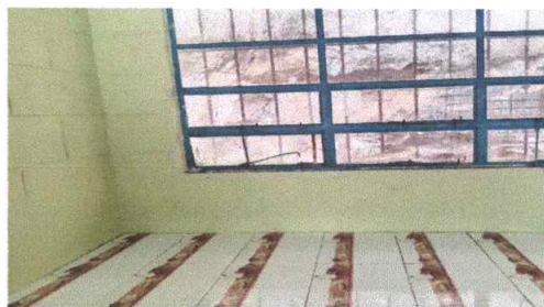
Foto 2: Sustrucción de azulejo en muebles de cocina
