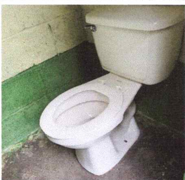
Foto 3: Sustrucción de inodoros
