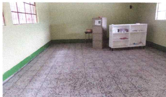
Foto 2: Sustrucción de piso de concreto por piso granito
