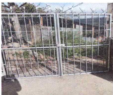
Foto 1: Sustrucción de porton de metal
