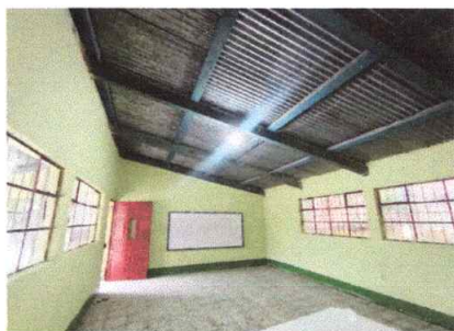
Foto 5: Sustrucción de lámparas tipo LED
