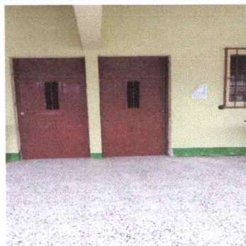
Foto 5: Sustitución de puertaS
