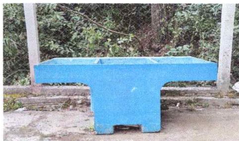
Foto 3: Sustrucción de pila de cemento de dos lavaderos
