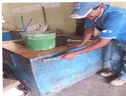
Foto 6: Sustitución de plancha de 3 hornillas
