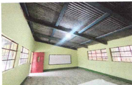
Foto 5: Sustitución de lámparas tipo LED
