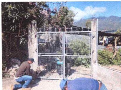
Foto1: Sustitución de porton de metal
