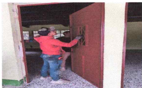
Foto 5: Sustitución de puertas
