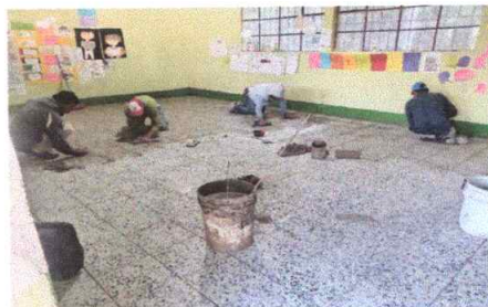
Foto 2: Sustitución de piso de concreto por piso granito
