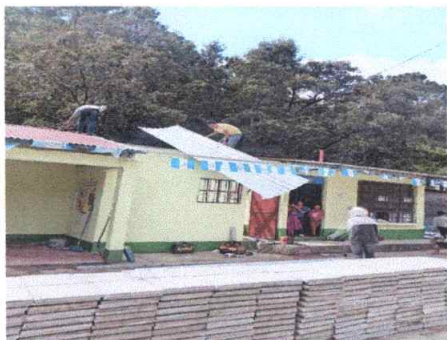
Foto1: sustitución de lamina por lámina troquelada aluzinc calibre 26
