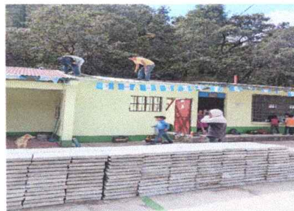
Foto 2: sustitución de capote de lámina por lámina troquelada
