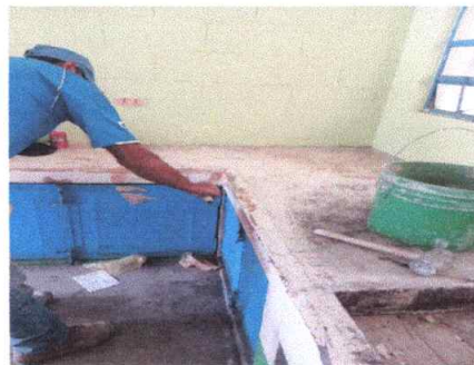
Foto 2: Sustitución de azulejo en muebles de cocina
