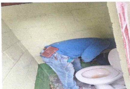
Foto 3: Sustitución de inodoros
