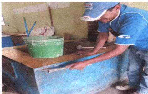
Foto1: Sustitución de azulejo en estufa rural
