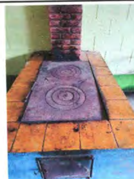
Foto 6: Sustrución de plancha de 3 hornillas
