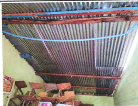
Foto 4: sustitución de estructura de soporte de madera de metal
