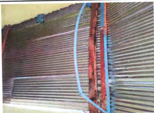
Foto 3: sustitución de elementos de fijación
