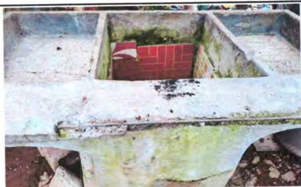
Foto 3: Sustrucción de pila de cemento de dos lavaderos
