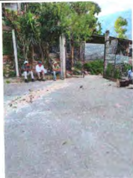
Foto1: Sustrución de porton de metal
