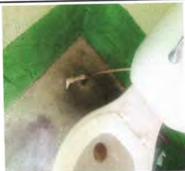
Foto 3: Sustrución de inodoros
