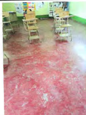
Foto 2: Sustrución de piso de concreto por piso granito
