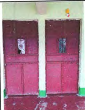
Foto 5: Sustitución de puertas
