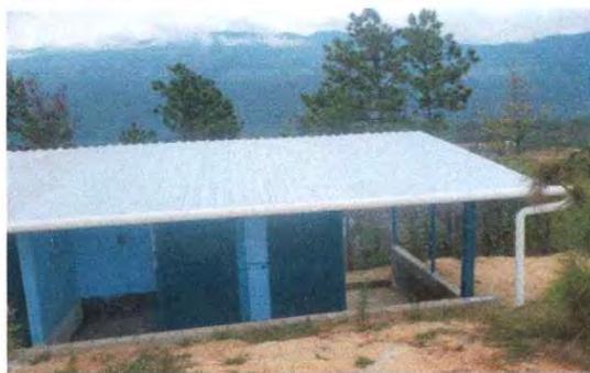
Foto1: 1.1 sustitución de lámina por lámina troqueada aluzinc calibre 26
