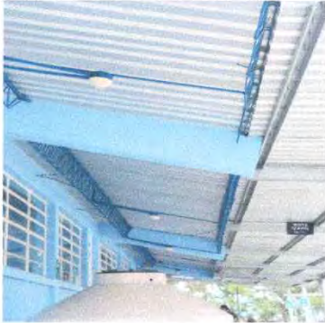
Foto 19: 14.5 sustitucion de plafonera
