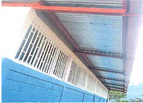
Foto 7: 9.2 Mejoramiento de paredes de aula
