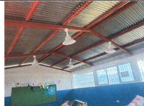
Foto 12: 17.3 Sustitución de lamparas tipo LED
