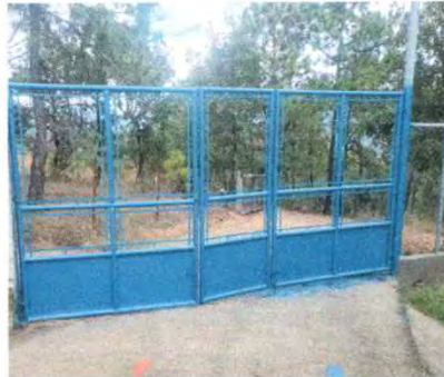
Foto 2: 12.1 Mantenimiento a portones de metal
