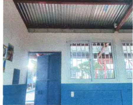
Foto 20: 17.11 sustitucion de ducto electrico + accesorio
