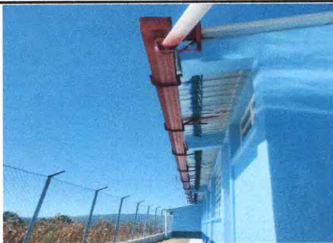
Foto 5: 7.1 sustitución de canal de metal
