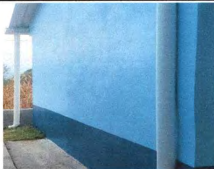
Foto 6: 7.3 Reparación de bajada de agua pluvial, tubo PVC 3"
