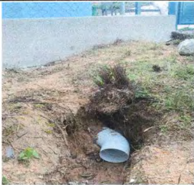
Foto 9: 14.4 Sustitución de tubería PVC línea principal aguas pluviales
