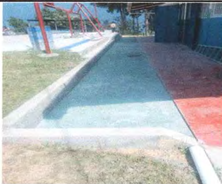
Foto 21: 6.1 Reparación de piso concreto
