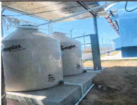
Foto 15: 18.3 Sustitución de deposito de agua 2, 500 lt
