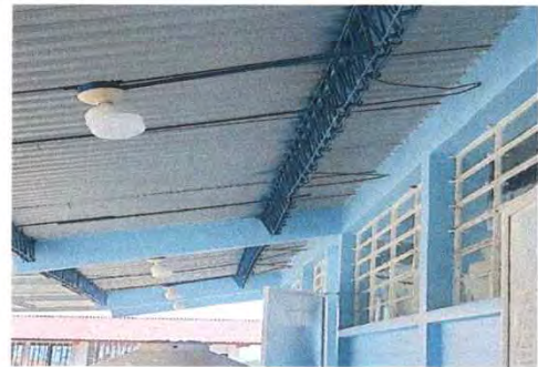
Foto 22: 17.5 sustitucion de focos ahorradores
