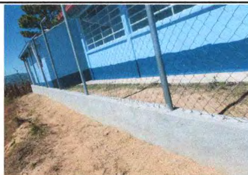
Foto 18: Repello en muro interior y exterior perimetral
