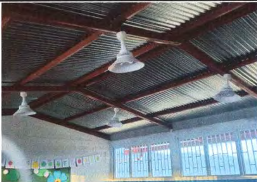
Foto13: 17.5 Sustitución de plafoneras
