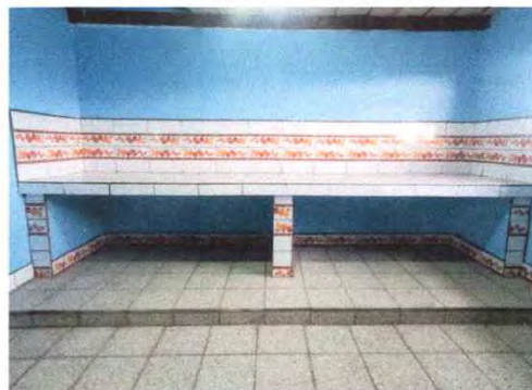
Foto 16: 20.8 Mejoramiento de azulejo en muebles de cocina
