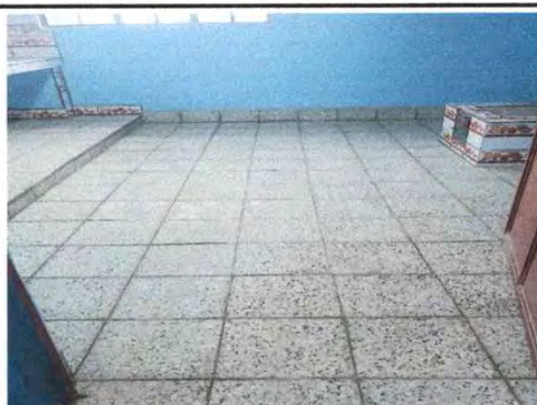
Foto 4: 6.8 sustitución de piso granito
