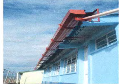
Foto 8: 7.5 Sustitución de soporte o pescante de metal para canal
