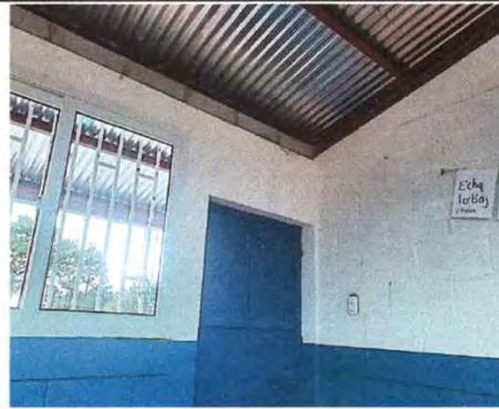
Foto 14: 17.11 Reparación de cableado eléctrico
