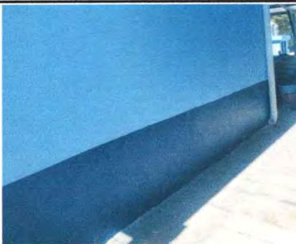
Foto 11: pintura en muros exteriores e interiores
