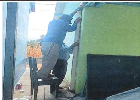
Foto 6: 7.3 Reparación de bajada de agua pluvial, tubo PVC 3"
