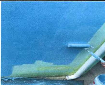
Foto 11: pintura en muros exteriores e interiores
