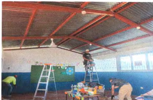
Foto13: 17.5 Sustitución de plafoneras
