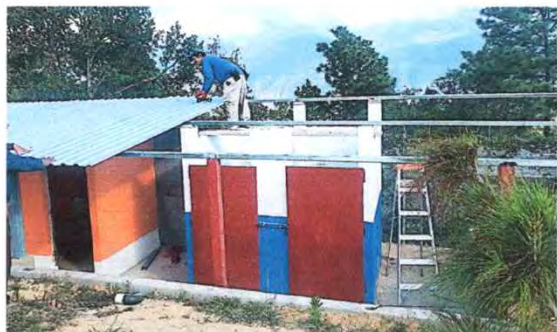
Foto1: 1.1 sustitución de lámina por lámina troqueada aluzinc calibre 26
