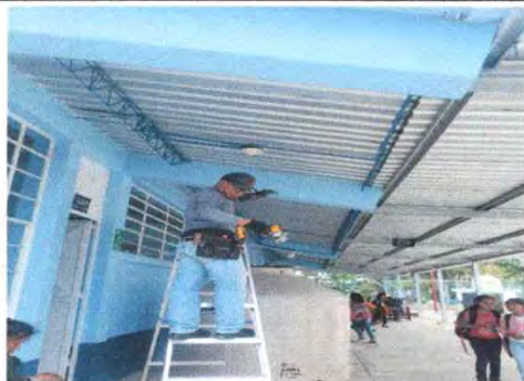
Foto 19: 14.5 sustitucion de plafonera
