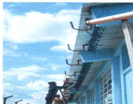
Foto 8: 7.5Sustitución de soporte o pescante de metal para canal
