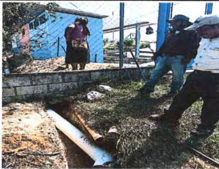
Foto 9: 14.4 Sustitución de tubería PVC línea principal aguas pluviales
