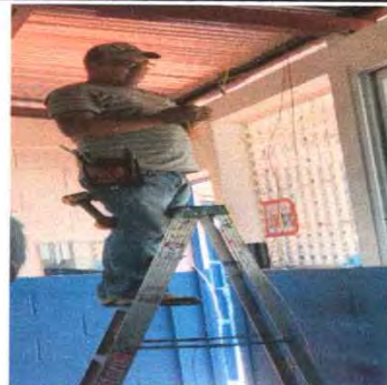
Foto 14: 17.11 Reparación de cableado electrico
