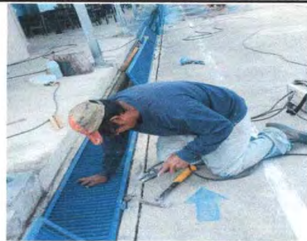
Foto 10: 8.1 Mantenimiento de parrilla de cuneta
