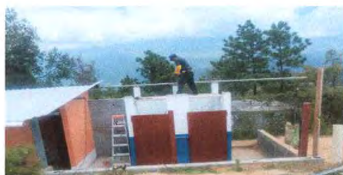
Foto 23: 2.4 sustitucion de estructura de metal, por metal
