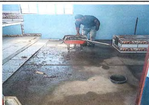
Foto 4: 6.8 sustitución de piso granito
