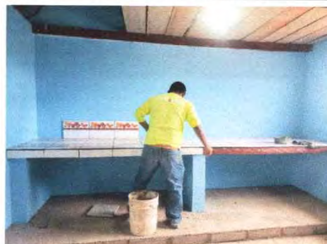
Foto 16: 20.8 Mejoramiento de azulejo en muebles de cocina
