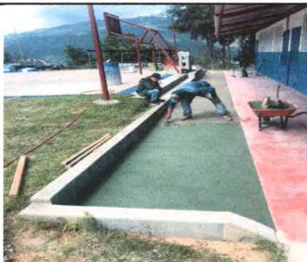
Foto 21: 6.1 Reparación de piso concreto
