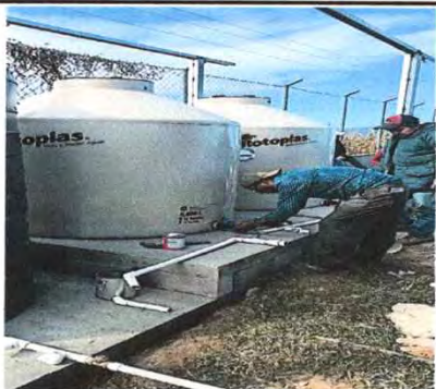
Foto 15: 18.3 Sustitución de deposito de agua 2, 500 lt
