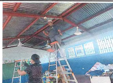
Foto 12: 17.3 Sustitución de lamparas tipo LED
