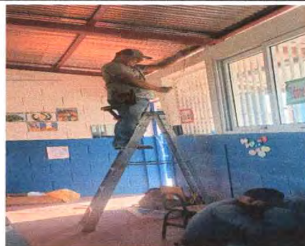
Foto 20: 17.11 sustitucion de ducto electrico + accesorio
