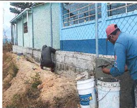
Foto 18: Repello en muro interior y exterior perimetral
