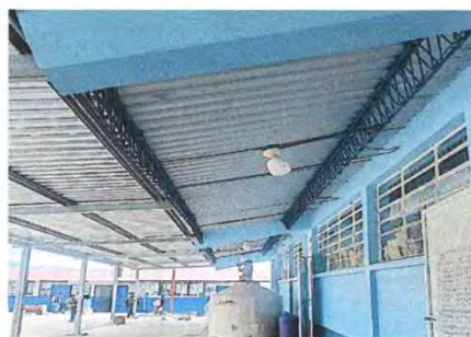
Foto 22: 17.5 sustitucion de focos ahorradores
