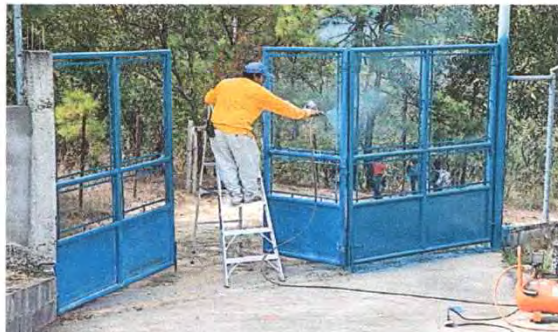
Foto 2: 12.1 Mantenimiento a portones de metal
