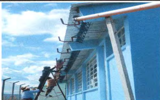
Foto 5: 7.1 sustitución de canal de metal
