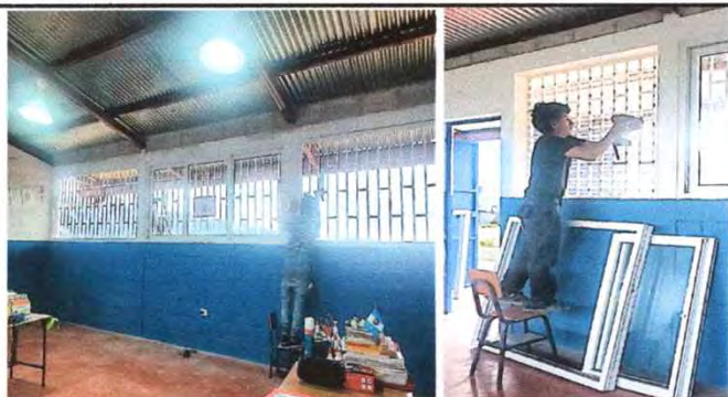
Foto 3: 5.8 Sustitución de estructura de ventana + vidreo para ventana
