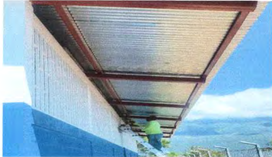
Foto7: 9.2 Mejoramiento de paredes de aula
