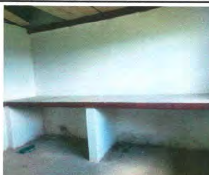
Foto 16: 20.8 Mejoramiento de azulejo en muebles de cocina
