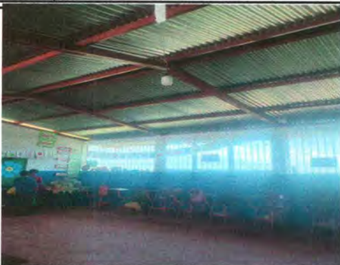
Foto13: 17.5 Sustitución de plafoneras
