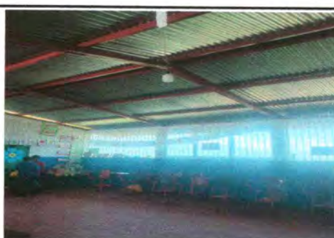
Foto 12: 17.3 Sustitución de lamparas tipo LED
