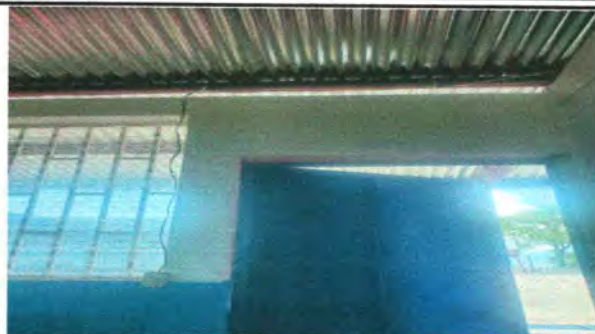
Foto 14: 17.11 Reparación de cableado eléctrico
