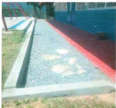
Foto 21: 6.1 Reparación de piso concreto
