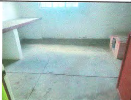
Foto 4: 6.8 sustitución de piso granito
