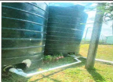
Foto 15: 18.3 Sustitución de deposito de agua 2, 500 lt
