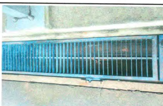
Foto 10: 8.1 Mantenimiento de parrilla de cuneta
