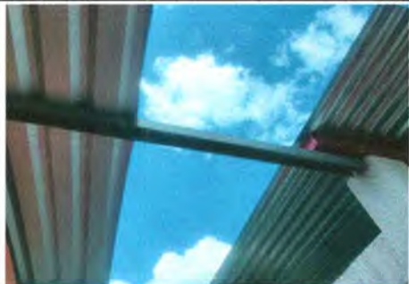
Foto 23: 2.4 sustitucion de estructura de metal, por metal
