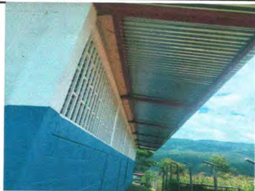
Foto7: 9.2 Mejoramiento de paredes de aula
