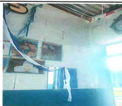
Foto 20: 17.11 sustitucion de ducto electrico + accesorio
