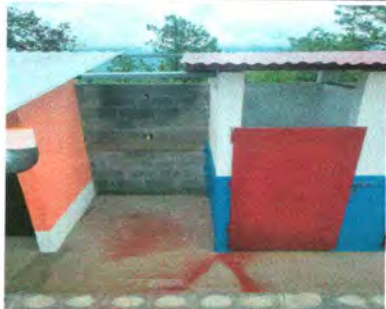
Foto1: 1.1 sustitución de lámina por lámina troqueada aluzinc calibre 26
