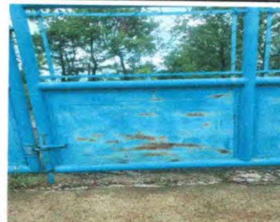
Foto 2: 12.1 Mantenimiento a portones de metal
