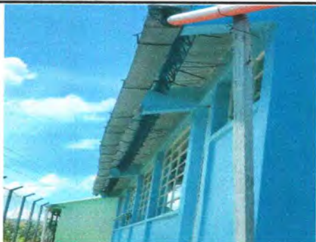
Foto 5: 7.1 sustitución de canal de metal
