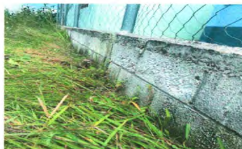
Foto 18: Repello en muro interior y exterior perimetral
