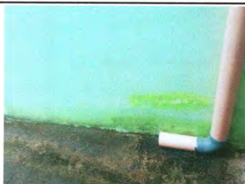
Foto 11: pintura en muros exteriores e interiores
