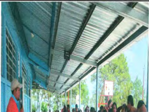
Foto19: 14.5 sustitucion de plafonera
